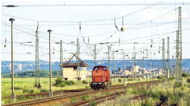
Erst auf den zweiten Blick offenbaren sich Sinn und Vielfalt des hier gerade erst fünf Jahre alten Kettenwerkes in Stotternheim nördlich von Erfurt. Die zahlreichen Betongewichte dienen zur Symmetrierung des Quertragwerkes bei späteren Nachrüstungen
