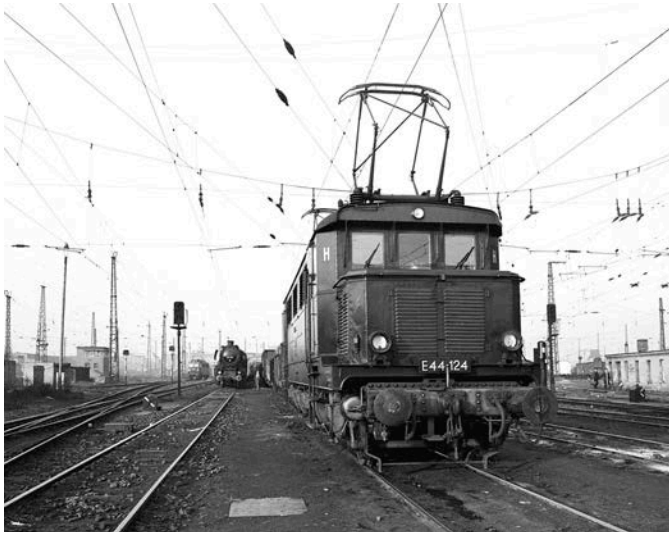
Fahrdrabtgewirr im Güterbahnhof Halle (Saale) 1963; oben links ist gut erkennbar, dass bei schlanken Kreuzungsweichen auch abzweigende Fahrleitungen durchaus den Anforderungen genügen
