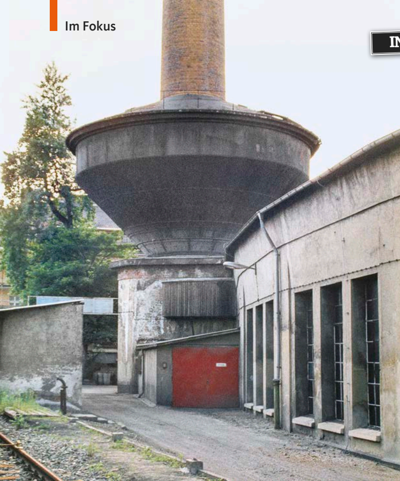
Die Intze-Bauart ermöglichte auch die Befestigung des Wasserbehälters um einen Schornstein herum, wie im Bw Leipzig Süd an der Lokschuppenesse ausgeführt
