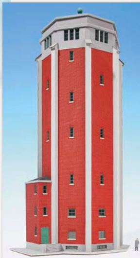
Der Wasserkessel der Bauart Intze – hier das HO-Modell HC9012 von Hornby – ruht in der Regel auf einem soliden Unterbau. Den Kessel schützt eine massive Umbauung vor niedrigen Außentemperaturen
