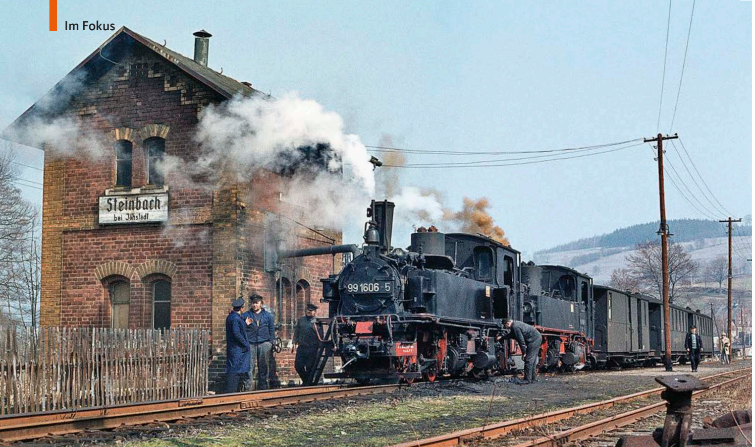
Der sächsische Schmalspur-Bahnhof Steinbach zeigt ein typisches Beispiel kleiner Wasserhäuser mit Wandwasserkran in der Bahnhofsausfahrt. Noch heute wird diese Wasserstation für die dampfenden Nostalgiezüge der Preßnitztalbahn benutzt Slg. Markus Tiedtke
