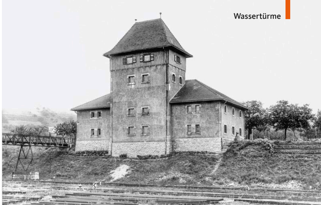
Mächtig thront dieser bayerische Wasserturm zusammen mit seinen Nebengebäuden am Hang oberhalb der Bahnanlagen einer unbekannten Station. Die höhere Lage vergrößerte natürlich die Wasser-Fallhöhe enorm
