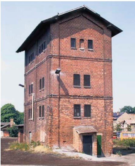
In Preußen setzte die Bahngesellschaft ihre runden und eckigen Wasserbehälter in massive Ziegelgebäude ein, wie hier am Bahnhof von Mirow praktiziert
