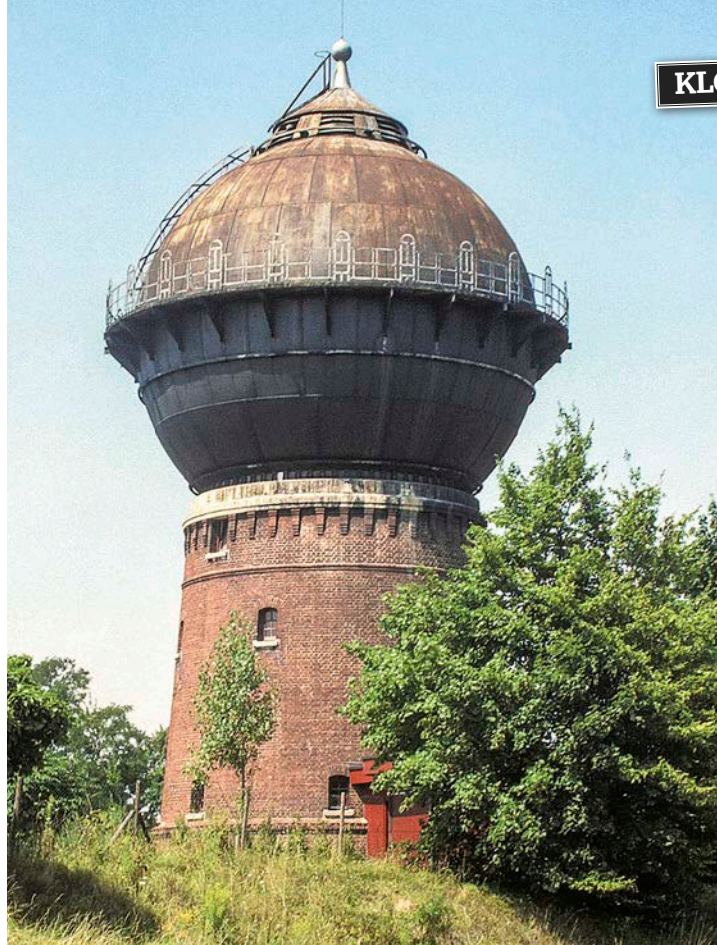
Im Bahnbetriebswerk Crailsheim ruht der Kugel-Wasserbehälter auf einem gemauerten Turm, so wie der Klönne-Wasserturm anfangs generell ausgeführt war
