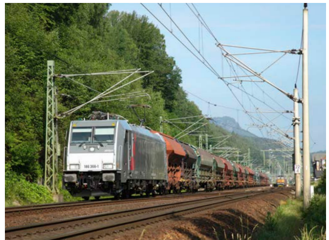
In der Ausfahrt von Bad Schandau im Elbsandsteingebirge ist aus dieser Perspektive nicht nur die Überspannung der Weichenverbindung erkennbar, sondern rechts auch die Fixpunktabspannung der Fahrleitung des Streckengleises Richtung Dresden
