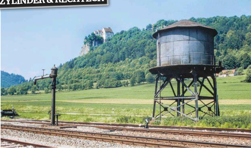
Der aufgeständerte, zylindrische Wasserbehälter im Bahnhof Hausen im Donautal ähnelt den Konstruktionen Nordamerikas; statt Holz wurde allerdings Stahl verwendet
