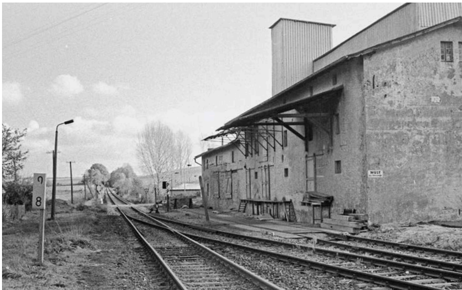
In Stolpen existierte eine mit dem Piko-Modell vergleichbare Ausführung, obgleich in puncto Silo etwas moderner. Die Anbindung erfolgte über eine Weiche im Kreuzungsgleis. Gut erkennbar ist das Gleisumfeld mit Betonplattenabdeckung
