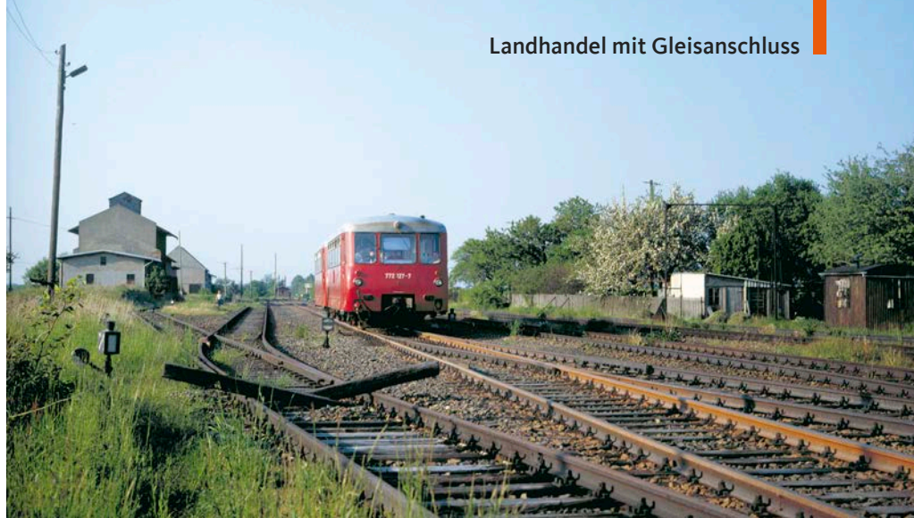
Das Getreidelager von Langenleuba-Oberhain war beidseitig angebunden und verfügte über ein eigenes Aufstellgleis. Im Mai 1994 kündigt das Schwellenkreuz bereits vom Siegeszug des Lkw
