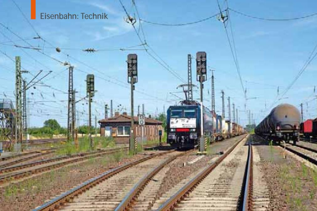
**Die Lichtsignale in Bischofsheim kollidieren nicht mit den Fahrleitungen. Aus diesem Winkel gut zu erkennen ist neben dem Bogenabzug links oben die elektrische Trennung der Aufstellgleise in der Ausfahrgruppe nach Norden mitsamt Einspeisung**
