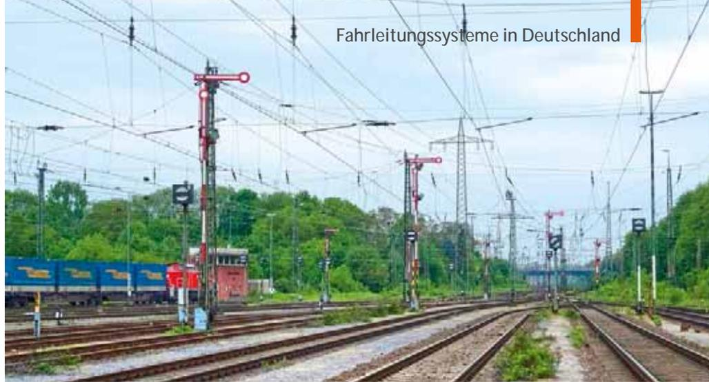
*In Köln-Eifeltor sind die Masthöhen der Formhauptsignale so gewählt, dass deren Flügel oberhalb der Fahrleitung liegen und damit nicht gekürzt werden mussten*
