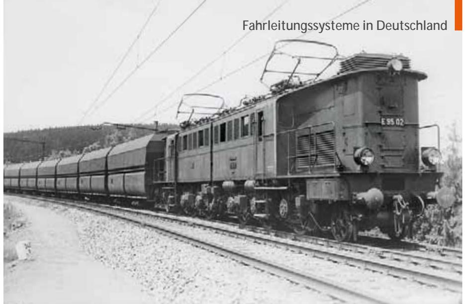
**Schwere Kohlezüge erforderten kräftige Lokomotiven, günstige Kohle erlaubte aber auch die Erzeugung von preiswertem Strom. Insofern stand die Baureihe E 95 seinerzeit für die moderne Reichsbahn. Gut erkennbar ist bei dieser Fahrleitungsänderung der Ausleger für zwei Gleise mit hoch liegendem Isolator für die Tragseile**
