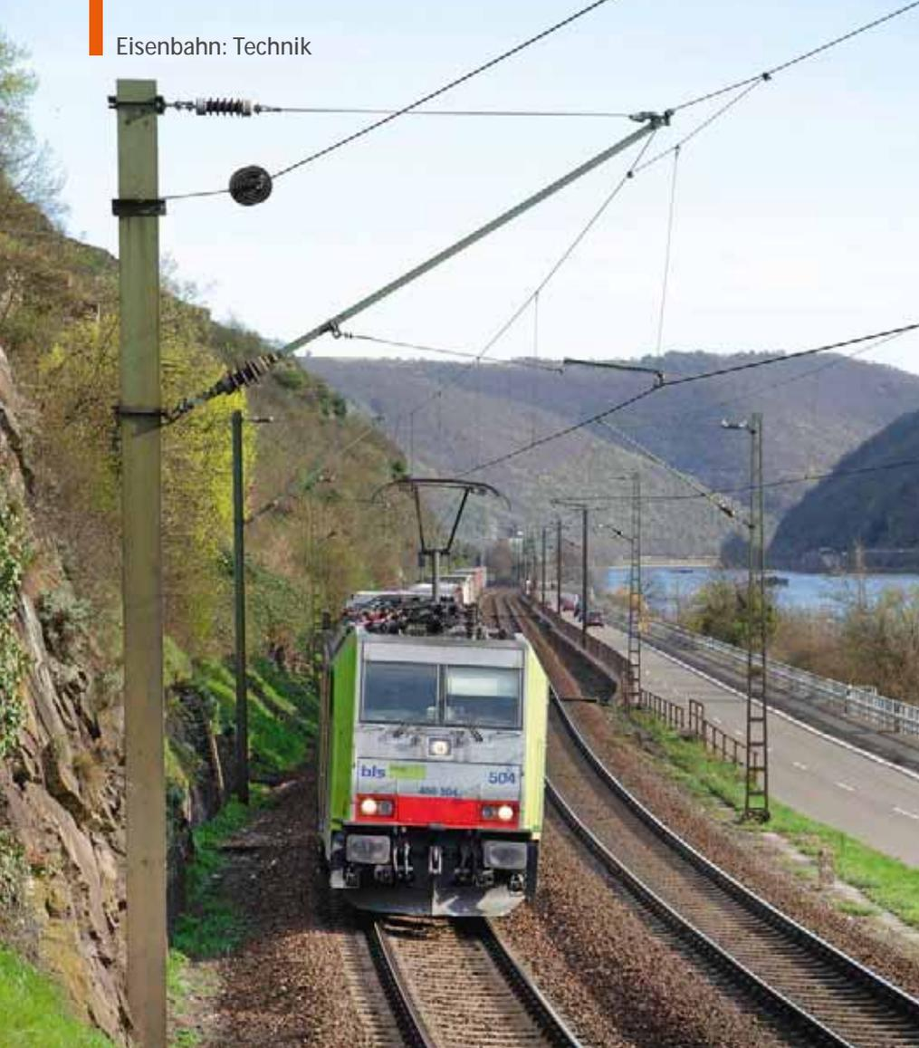
*Die Rhein-Strecken mit ihren beengten Platzverhältnissen erforderten von der Bundesbahn Sonderlösungen beim Fahrleitungsbau in Form von Peinert-Masten aus H-Profilen*
