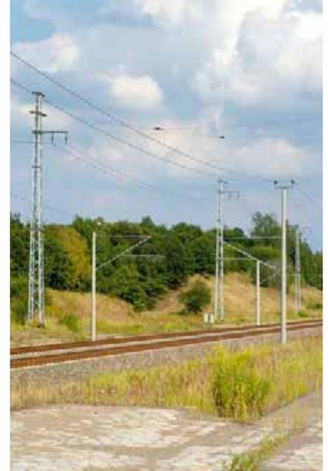
**Durch den Rückbau von Gleisen wurden in Waren die alten DR-Tragwerke entbehrlich. Ein Teil der Masten wurde noch für die Speiseleitungen gebraucht. Für die modernisierte DB AG-Strecke genügt fortan eine einfache Fahrleitungslösung**
