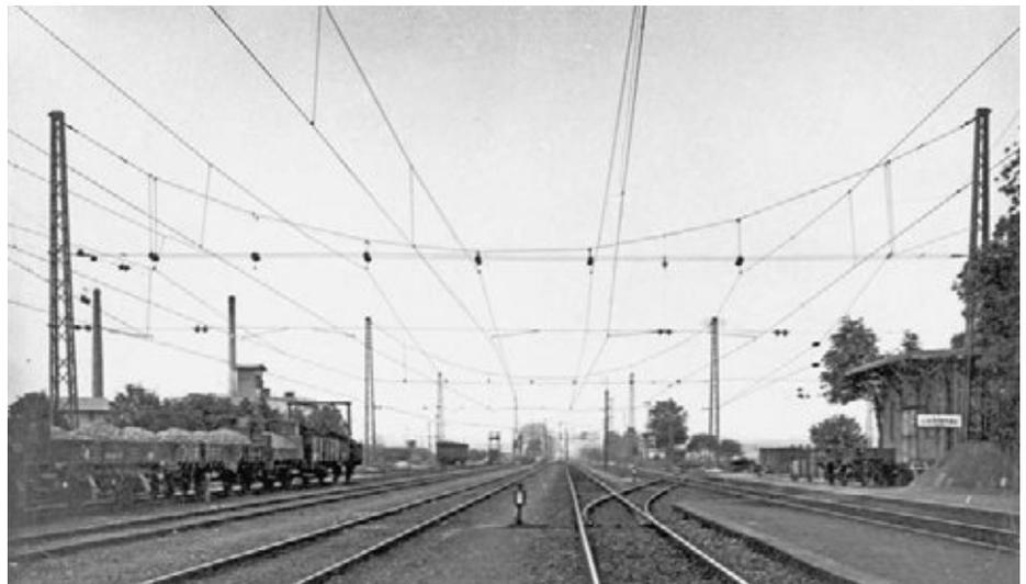
**Das Tragwerk im Bahnhof Lichtenau entspricht in seiner Form von vor einhundert Jahren den bis heute gültigen Fahrleitungsbaugrundsätzen**
