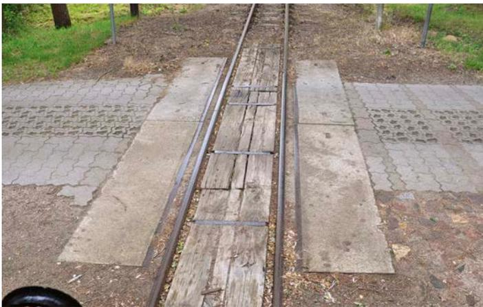
**An diesem Bahnübergang beim „Pollo“ werden die Bohlen zwischen den Schienen lediglich mit Spannbändern gesichert**
