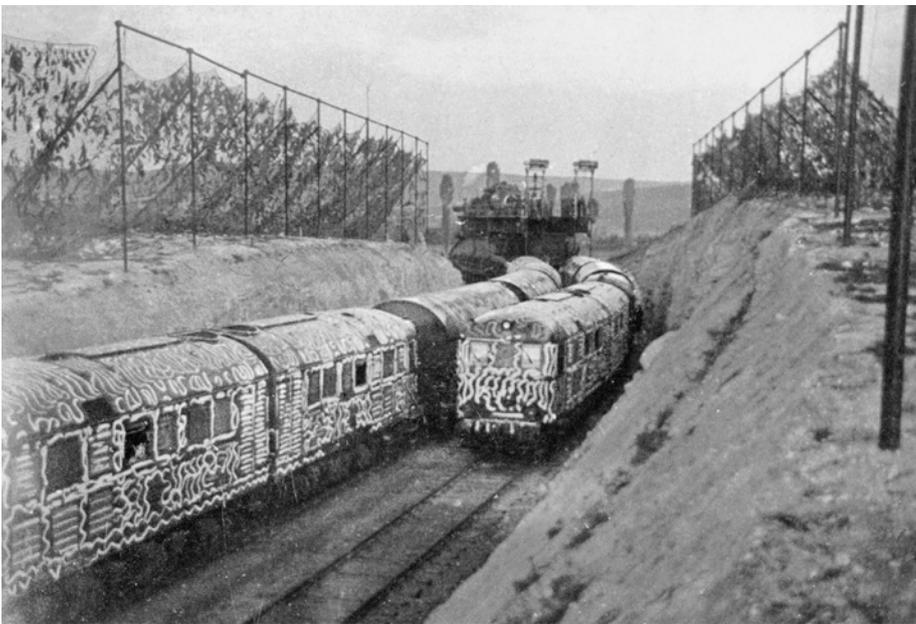
**Vom Einsatz der beiden Doppelloks D 311.01 und 02 vor dem schweren Eisenbahngeschütz „Dora“ bei Sewastopol gibt es nur wenige Aufnahmen. Gut zu sehen ist der eigens angelegte Einschnitt mit dem Doppelgleis und der Schießkurve**
