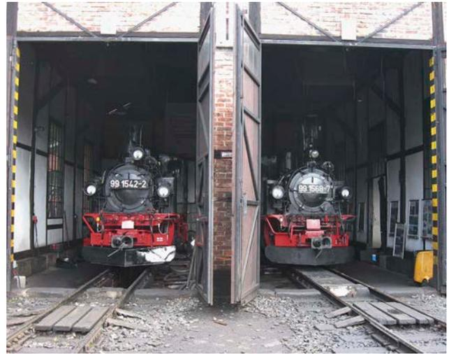
**Bei dieser Sparversion sind die Bohlen nur zwischen den Schienen verlegt. Zusätzlich gibt es kleine Rampen, um mit Hand- oder Schubkarren die Gleise queren zu können**
