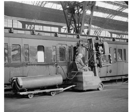
**Im Juni 1961 im Leipziger Hauptbahnhof fotografierte Neuererlösung einer mobilen Zugreinigungsanlage**
