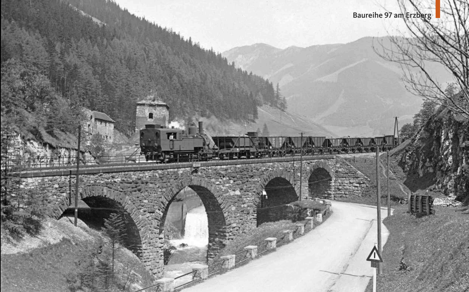
Typisch für die Erzbergbahn waren die kleinen zweiachsigen Erztransportwagen in unterschiedlicher Bauausführung. 97 217 befördert einen mit Eisenerz beladenen Zug am 24. Mai 1942 über den Viadukt bei Vordernberg talwärts
