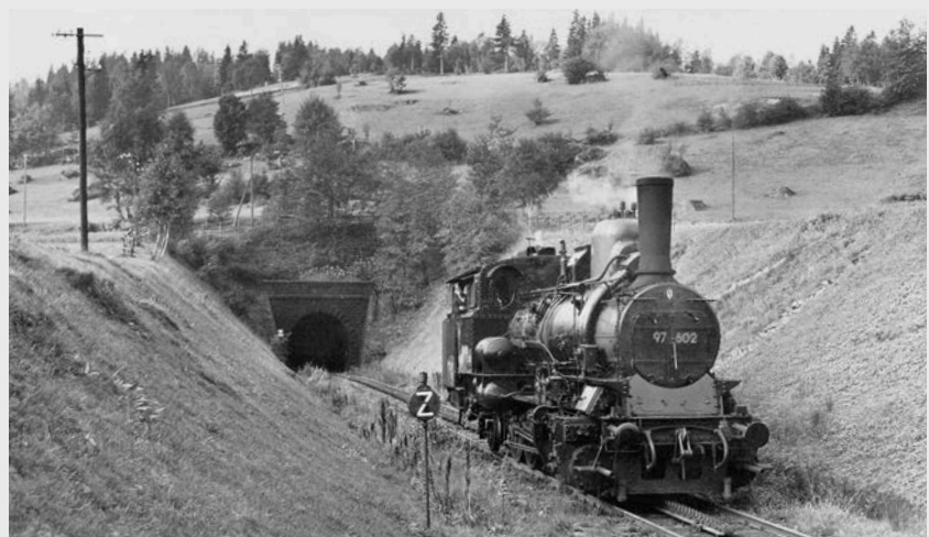
Die Zahnradstrecke der Reichenberg-Gablonz-Tannwalder Eisenbahn wurde ab 1902 von den kkStB betrieben, die ihre drei Zahnradloks als Reihe 169 bezeichneten. 1940 fährt 97 602 nahe des Przychowitzer Tunnels
