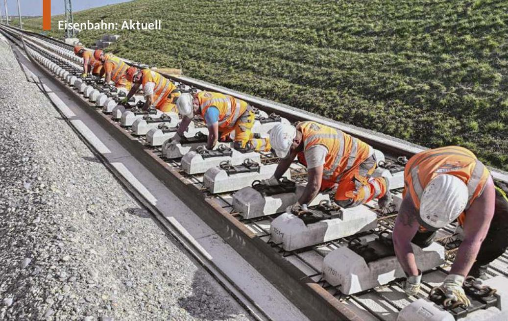
**Der Oberbau auf der Neubaustrecke nimmt am 6. April 2020 Gestalt an. Bauarbeiter verlegen Betonschwellen für die Feste Fahrbahn System Rheda 2000. Erste Masten für die Oberleitung stehen bereits** *Arnim Kilgus/DB AG*
