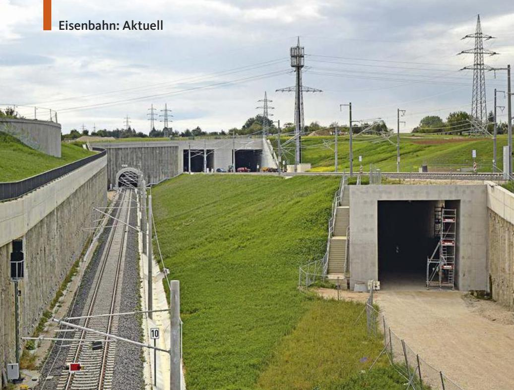
Abzweig Neckartal bei Wendlingen am 3. September 2022: links die eingleisige Anbindung der Güterzugkurve, die ab Dezember 2022 befahren wird. In Bildmitte die beiden Tunnelleinfahrten der Strecke Richtung Flughafen und zum künftigen Stuttgarter Tunnelbahnhof. Unten die Tunnelleinfahrt für die zukünftige Anbindung der Strecke aus Tübingen
