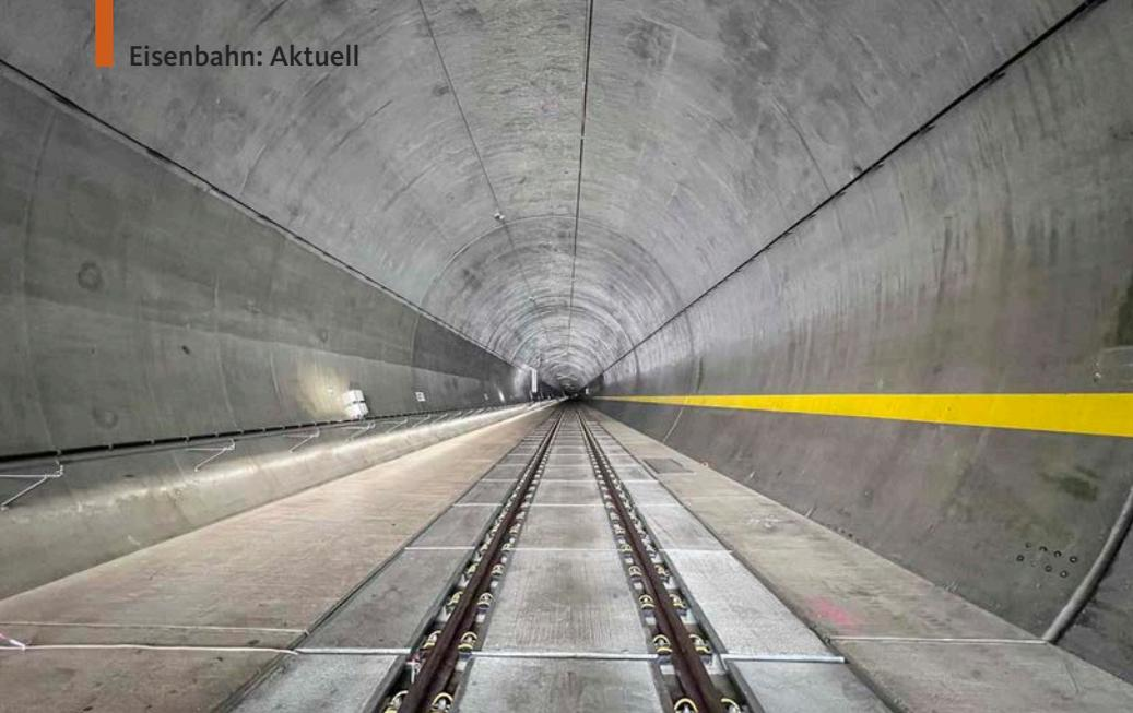
**Blick in die Röhre des Steinbühltunnels (4.846 Meter). Der gelbe Streifen an der Wand signalisiert, dass es sich um das Richtungsgleis Wendlingen – Ulm handelt**
