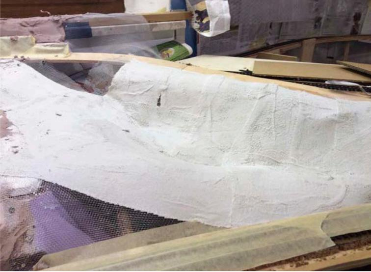
**Auf Alugewebe aufgezugene Gipsbinden aus dem Pharmaziebedarf eignen sich gut für größere Flächen und speziell für Stellen, wo Gleistrassen darunter verlaufen. Allerdings halten Bäume nur bedingt darauf**
