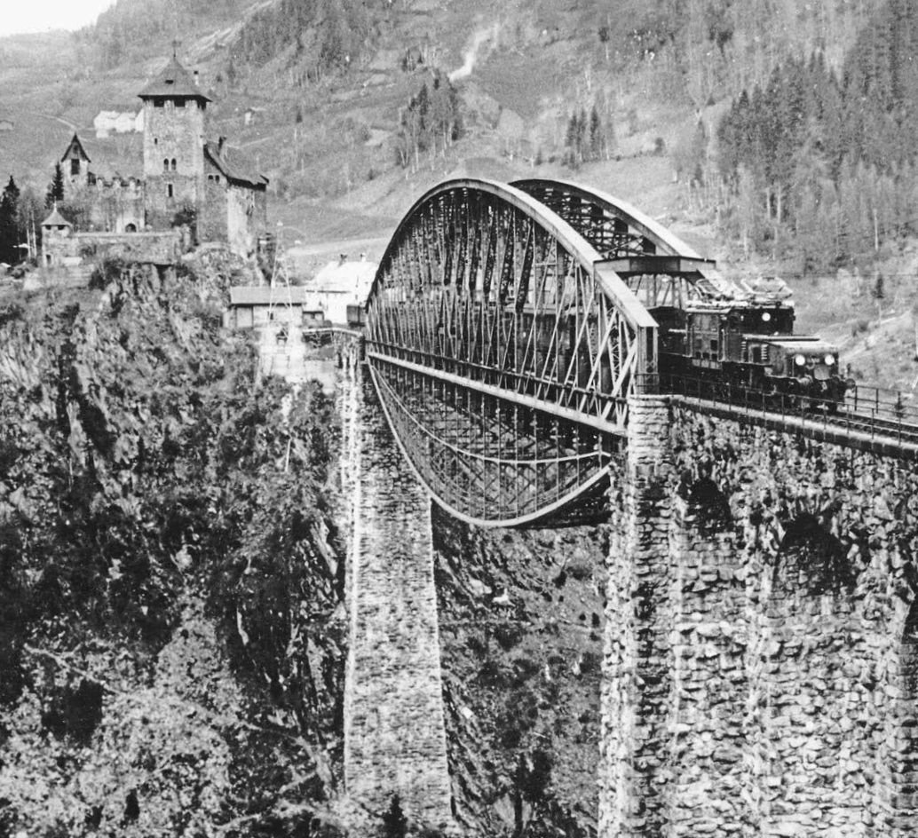
Die 1884 in Betrieb genommene Trisannabrücke wurde 1923 mit einem Fischbauchträger verstärkt. Eine der Arlbergbahn-Güterzugloks der BBÖ-Reihen 1100/1100.1 rollt 1938 über das technische Meisterwerk RVM/Slg. Eisenbahnstiftung
