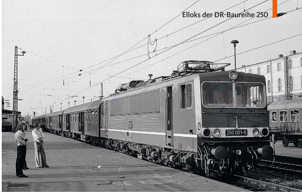
**Die Pause beim Kuppeln der 250 001 in Magdeburg nutzen zahlreiche Reisende zum Bestaunen des ungewohnt kantigen Prototyps der neuesten DR-Maschine. Abweichend von der Serie sind die Fenster deutlich größer und das Spitzenlicht ist oberhalb der Frontfenster montiert**
