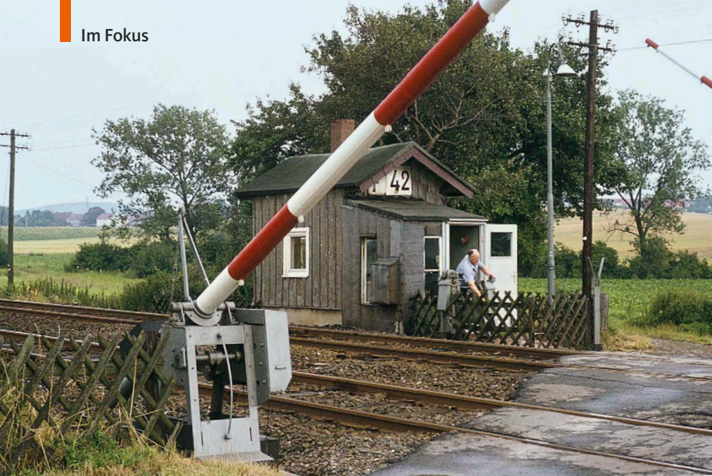
Das holzverschaltete Gebäude von Posten 42 lag an der Strecke Salzgitter-Ringelheim – Salzgitter Bad; es wurde längs zum Gleis errichtet Wolf-Dietmar Loos
