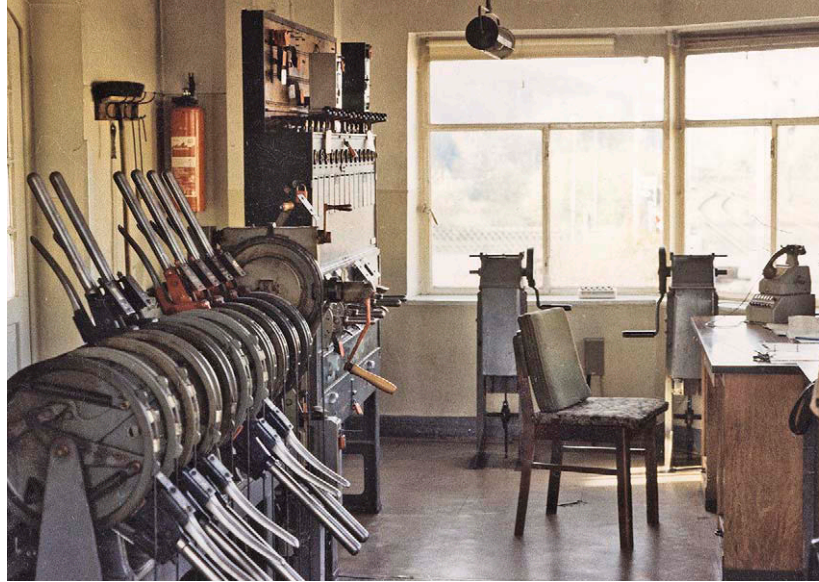
In Neheim-Hüsten gab es – wie in vielen Fällen bei DB und DR – ein Stellwerk, von dem aus auch Schranken bedient wurden (siehe die beiden mechanischen Schrankenwinden). Die Aufnahme entstand 1984
