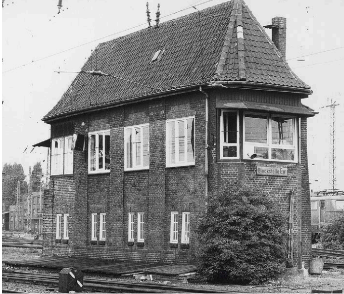
Das Wärterstellwerk Eidelstedt West hieß „Blockstelle Ew“. Der Grund: Von dort wurde auch ein Blocksignal an einem Hauptgleis gestellt, der Blockwärter agierte als Fahrdienstleiter (Foto: 1975)
