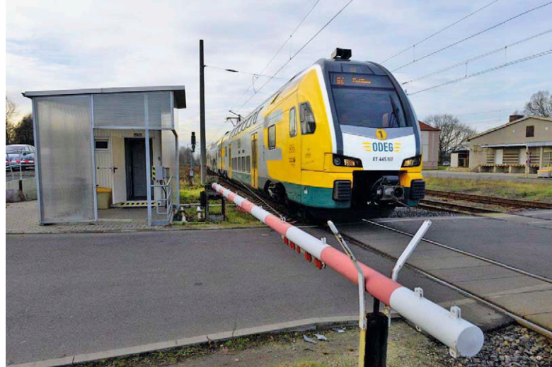
Vom Wetter unbehelligt arbeitet der Schrankenwärter an diesem Posten in Cottbus (2013). Schon die kleine Bildauswahl des Beitrags zeigt die enorme Vielfalt bei den Postenhäuschen Volker Emersleben
