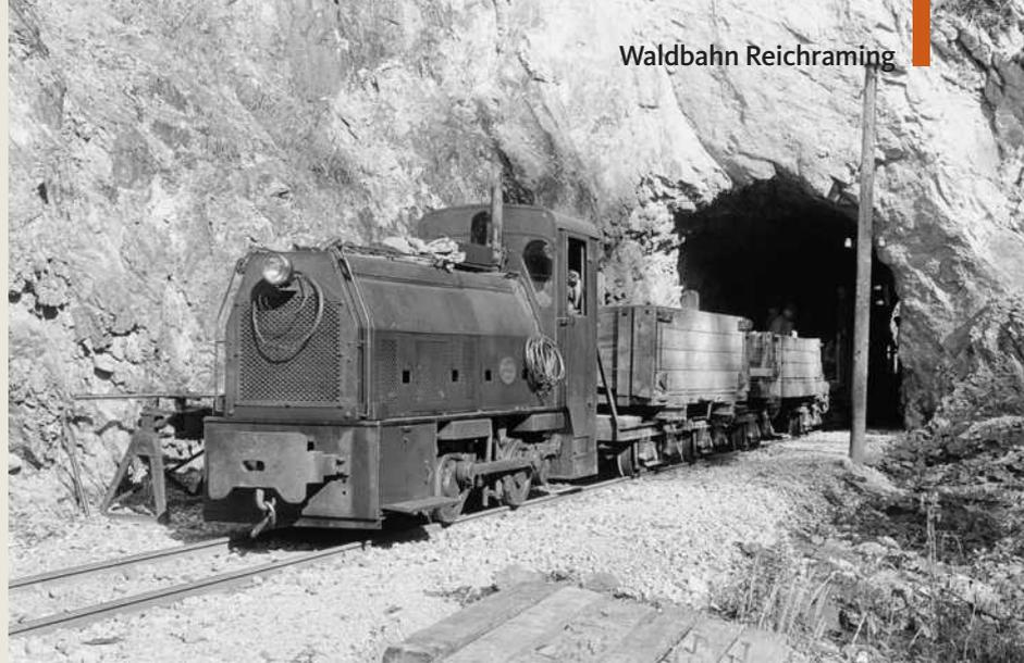
**Insgesamt 19 Tunnel mit einer Gesamtlänge von fast 2.000 Metern mussten für die Waldbahn in den Fels getrieben werden. Lok 4 verlässt am 11. September 1957 einen Durchbruch im Verlauf der Hintergebirgsstrecke**
