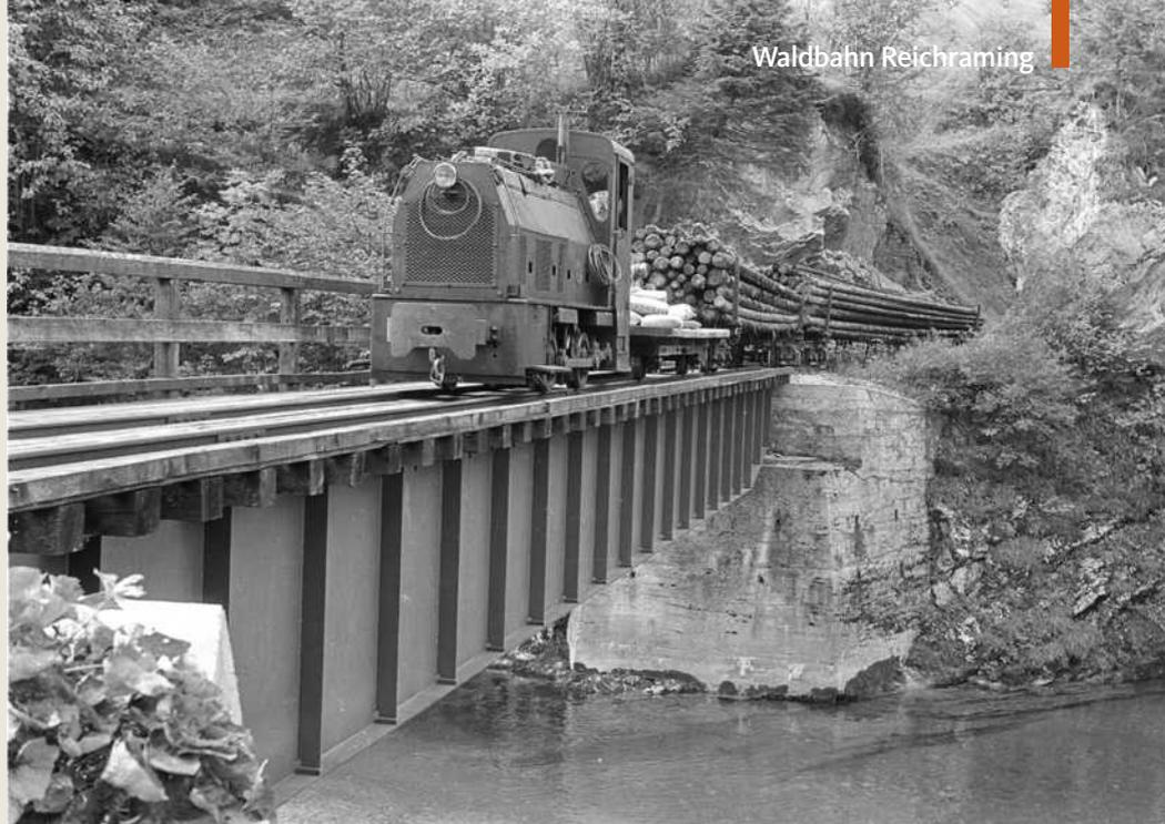
Die solide Anlage der Waldbahn Reichraming zeigt sich unter anderem in der Ausführung dieser massiven Brücke, die am 11. September 1957 ein Zug mit Lok 4 überquert *Alfred Luft (3)*
