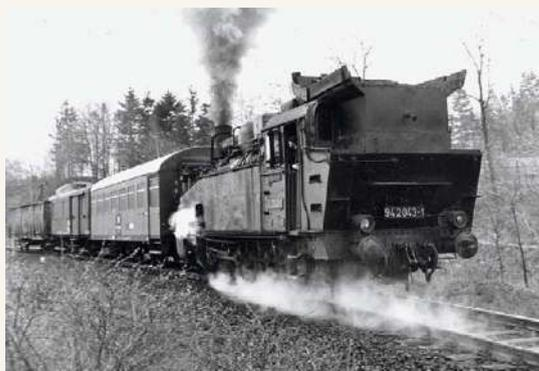
Die Reichsbahn-Baureihe 94<sup>20-21</sup> fuhr bis 1975 im Schubbetrieb auf der Eibenstocker Steilstrecke
