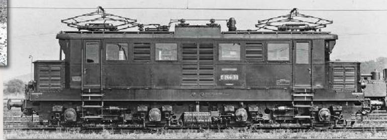
**E 244 31 (Foto in Freiburg, 1937) besaß Einphasenmotoren mit Zwischenläufern der Bauart Schön**
