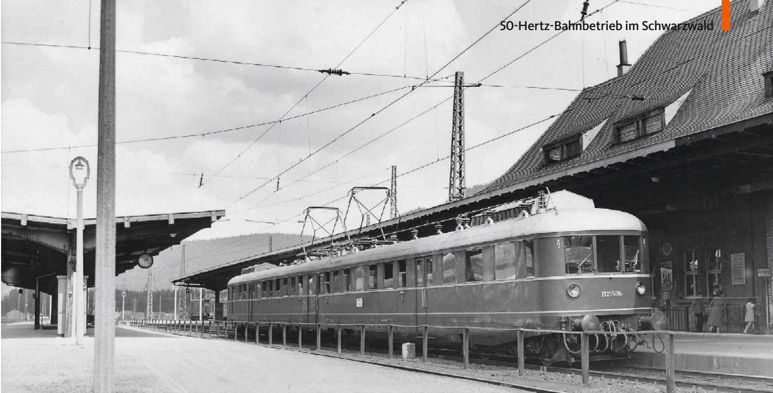
**Auf der Grundlage des Triebwagens ET 25 026 entstand 1950 der ET 255 01 (Foto in Titisee) für die 50-Hertz-Strecken im Schwarzwald**
