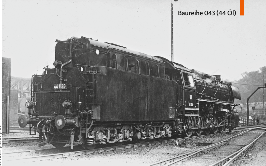
Bis 1967 fanden die Öl-44 eine Heimat beim Bw Kassel, an dessen Sterngleisen 44 1133 in den 60er-Jahren abgestellt ist und das Studium des Öltenders erlaubt
