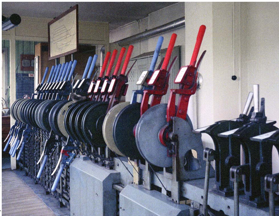
Schliersee hatte 1913 im nordwestlichen Teil des Bahnhofs ein mechanisches Hebelstellwerk der Bauart Krauss erhalten. Das Foto entstand im Jahr 1973. Noch im Laufe des Jahres 2021 soll es nach Plänen von DB-Netz stillgelegt werden
