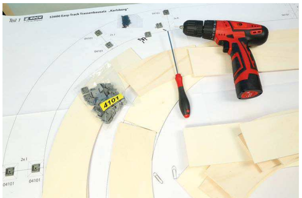
Nachdem der Verlegplan auf der Grundplatte fixiert ist, werden die ersten Basisplatten der Pfeiler aufgeschraubt. Besonders schnell erledigt ist das mit einem Akkuschrauber
