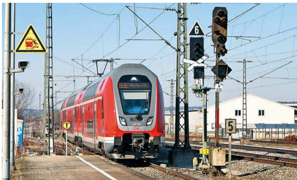
Das Sk-Ausfahrtsignal in Mertingen besitzt einen Signalschirm aus den 1950er-Jahren. Die Lf 7-Tafel davor zeigt „5“ für die Ausfahrt mit 50 km/h an. Hinten ist ausgekreuzt schon ein Ks-Signal aufgestellt, dass das Sk-Signal wohl Ende 2021 ersetzen wird (Foto vom 28. Februar 2021)
