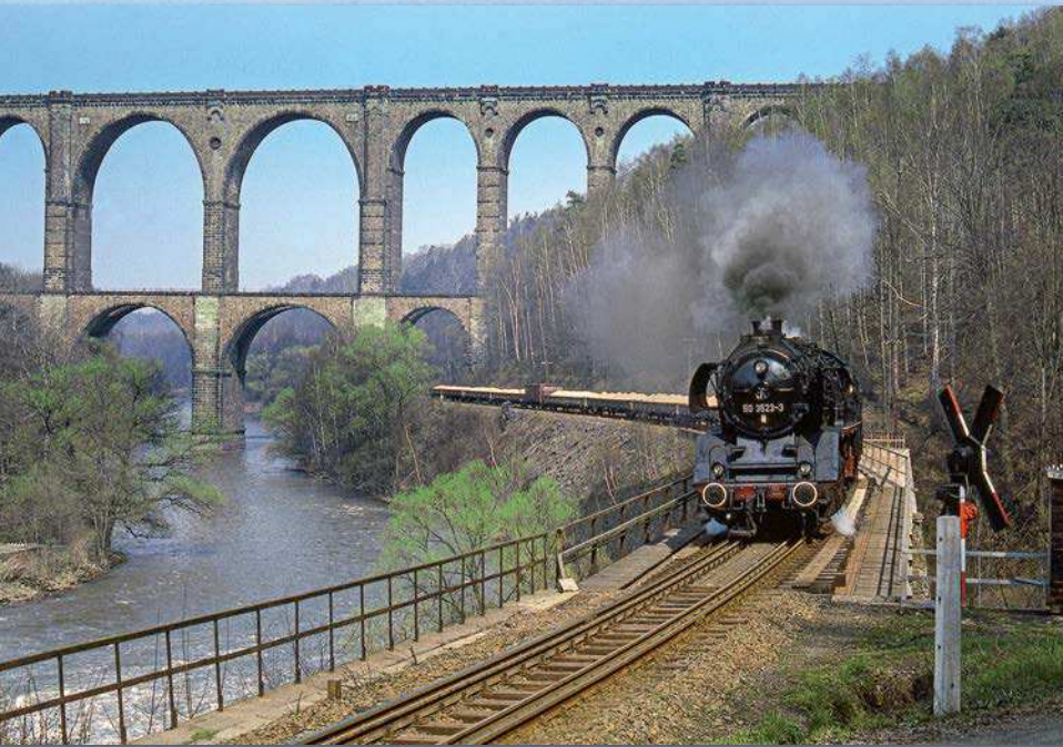
Auf dem Göhrener Viadukt quert die Bahnstrecke Chemnitz – Leipzig das Tal der Mulde. Am 23. April 1987 hat 50 3523 das imposante Bauwerk soeben passiert
