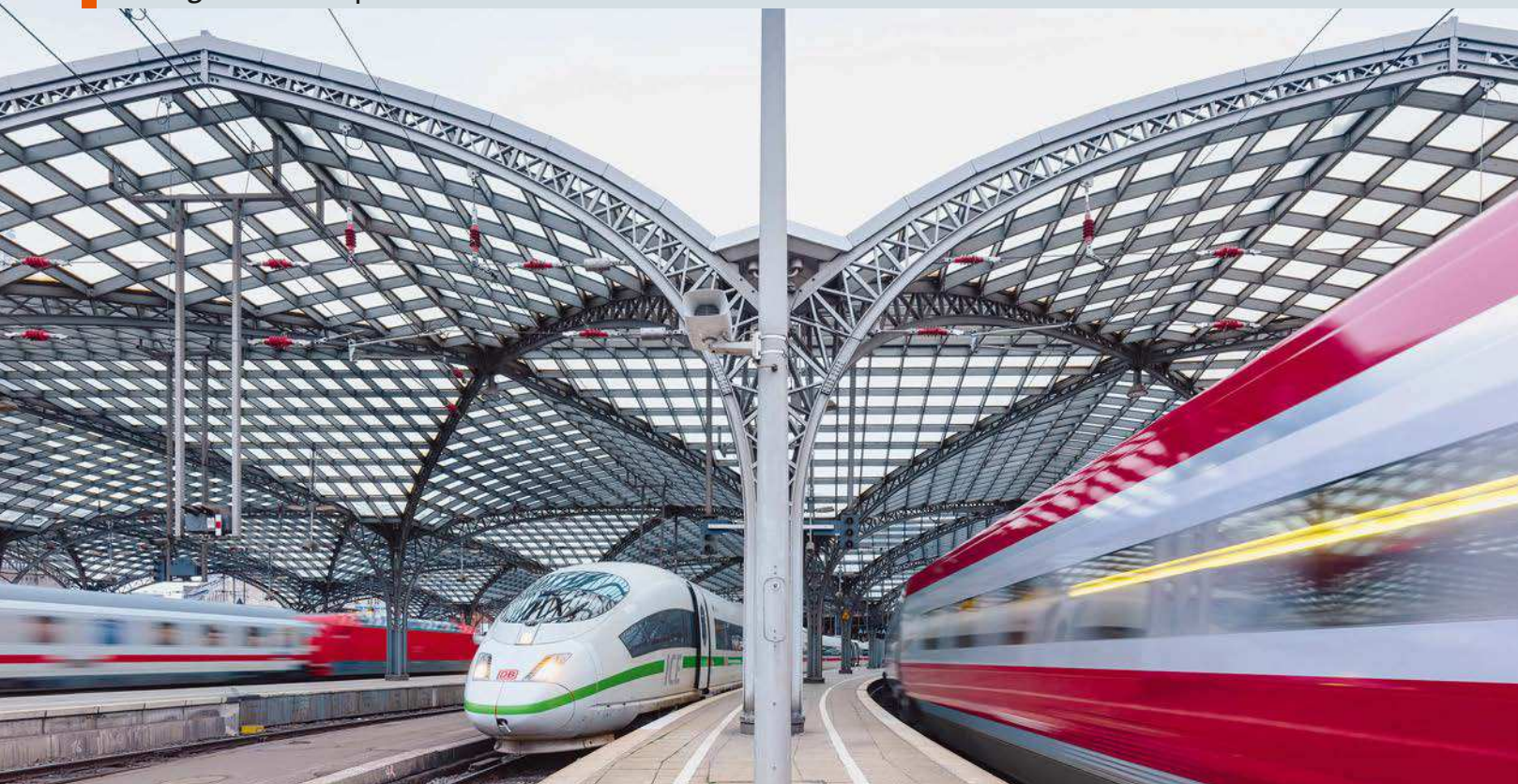
Einen dreistelligen Millionenbetrag investiert die Deutsche Bahn 2021 in die Kapazitätserweiterung des Knotens Köln. Am Hauptbahnhof (Foto) geht im Herbst ein neues elektronisches Stellwerk in Betrieb
