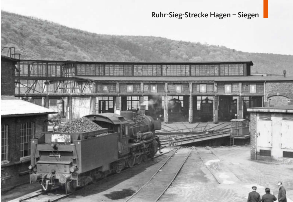
Am Bw Eckesey legt 38 2225 am Nachmittag des 3. Mai 1965 eine kurze Schaffenspause ein
