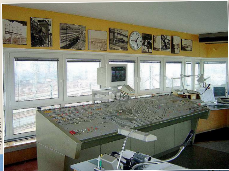
Blick ins Stellwerk Af mit dem Stelltisch des Relaisstellwerks vom Typ SpDr S 59 (Foto vom 19. März 2005)
