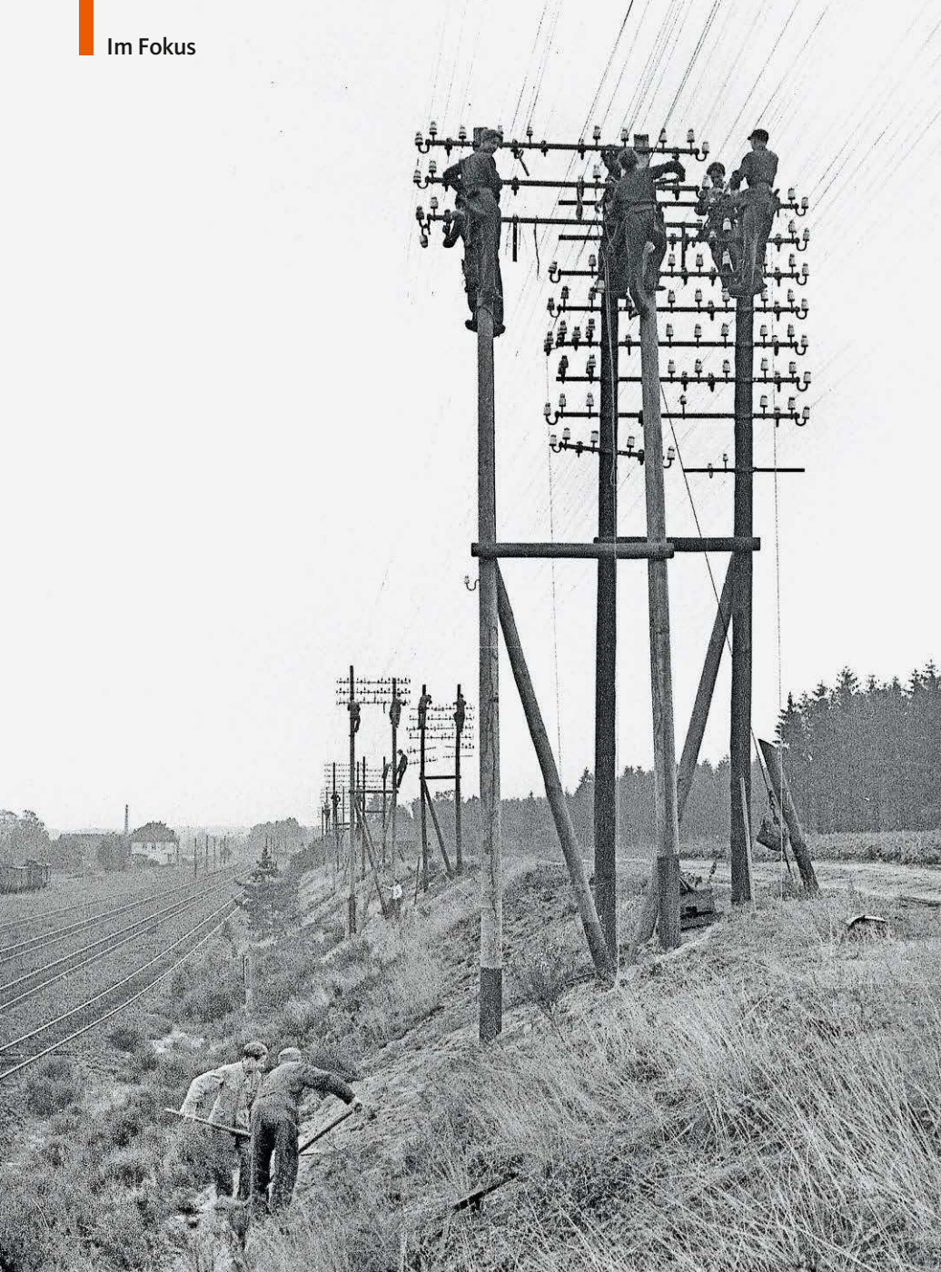
Das Setzen und der Umbau von Freileitungen geschahen in mühsamer Handarbeit. Im Jahr 1938 hatte der Fernmeldetrupp der Reichsbahn mit dem Umbau von Doppelstangen-Masten bei Wittenberge zu tun
