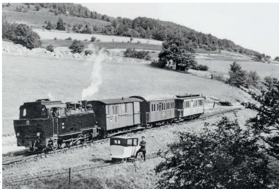
Den Abstieg von Küstelberg nach Wissinghausen bewältigte die 750-Millimeter-Schmalspur- bahn Steinhelle – Medebach mit zwei Spitzkehren (Foto mit Lok 7 in den 1930er-Jahren)
