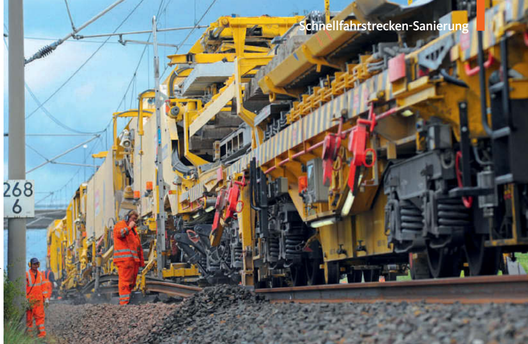
Der Schnellumbauzug SUM 315 der DB Bahnbau Gruppe ist mit seiner rationellen Arbeitsweise prädestiniert für den Einsatz an zu sanierenden Schnellfahrstrecken
