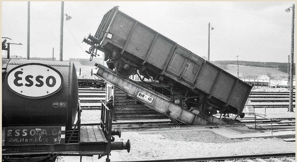
**Wagenentladung mithilfe einer Kippe im Deckenbaubahnhof Schlüsselfeld. Die Kesselwagen dienen zum Transport von Kraftstoff für die Baumaschinen und heißem Bitumen für die Straße**
