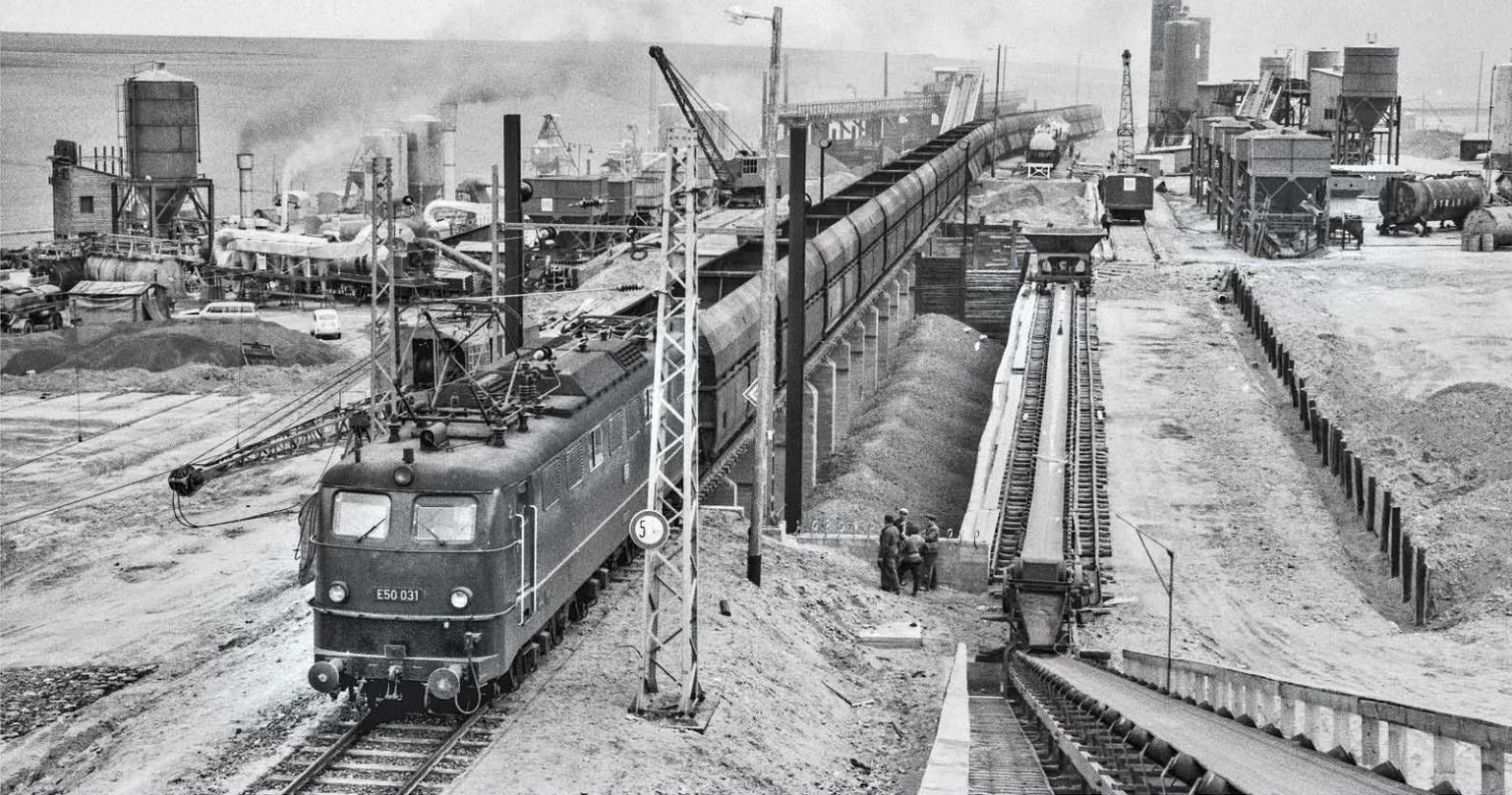
**Der Deckenbaubahnhof Dettelbach lag an der Hauptbahn Nürnberg – Würzburg und war elektrifiziert. Die E 50 031 hat Baumaterial gebracht, das mit dem Förderband rechts zu einem Hochbunker befördert wird. Lkw transportieren es weiter zur Baustelle**
