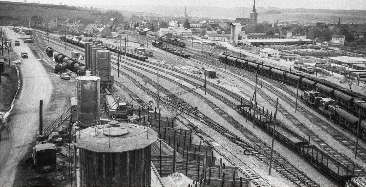
In Schlüsselfeld, am Endbahnhof der Nebenbahn von Strullendorf, errichtete die DB einen Deckenbaubahnhof für den Autobahnbau. Die Anlagen des Baumaterial-Umschlagplatzes übertreffen den alten Bahnhof (hinten) bei Weitem
