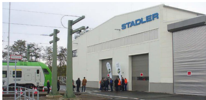
Zwei Hallengleise und eine Waschanlage ermöglichen Wartung und Pflege der FLIRT-Triebzüge am Stadler-Standort Herne
