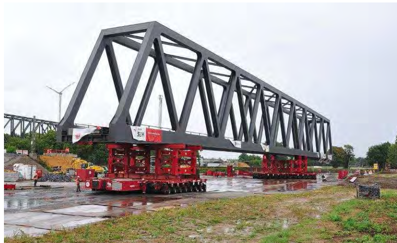
Am 15. August 2019 wird die 1.600 Tonnen schwere Ruhrbrücke zu den Widerlagern gefahren
