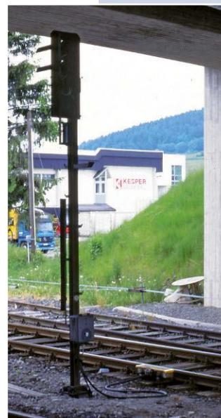
In der Rückansicht ist die Kabelführung vom Gleismagnet zum Schaltkasten unten am Signalmast erkennbar. Bei Lichtsignalen sorgt ein Relaiskontakt im Mastschaltkasten für die Scharfstellung des Gleismagneten abhängig vom Signalbild.
