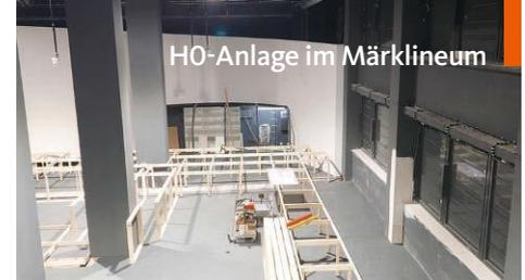
**Aufbau der Anlagen-Grundrahmen; hinten die Projektionswand und dahinter der spätere Steuerungsraum der Anlage**
