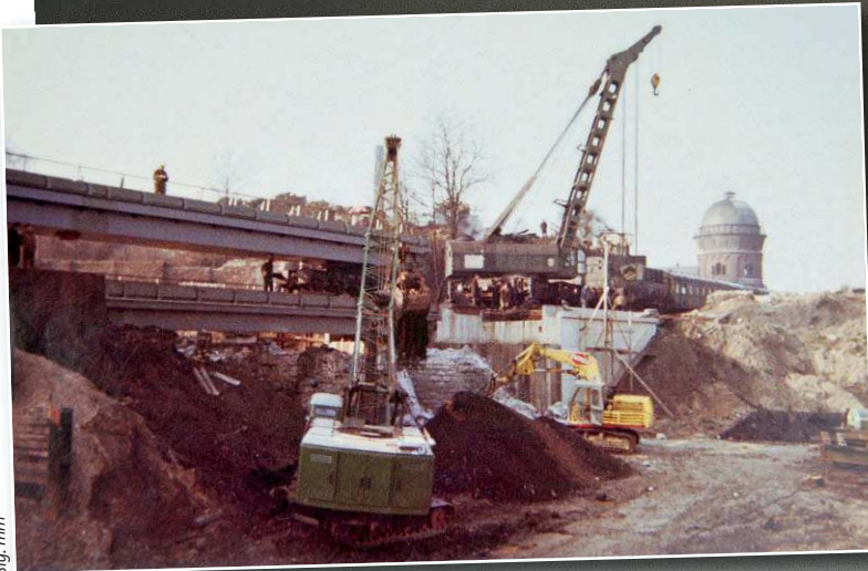
Farbfotos vom Kraneinsatz sind selten. Bereits während der Epoche IV setzte der Dampfkran ein neues Brückenelement in Mülheim-Broich ein. Angehängt sind der Wagen mit Gegengewichten, der Wasser- und Mannschaftswagen
