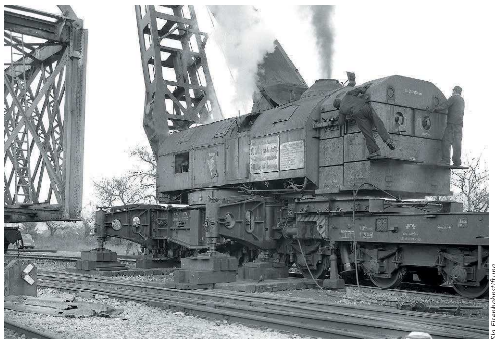
Für den sicheren Stand müssen immer ausreichend Holzbohlen mitgeführt und ausgelegt werden. Gut zu erkennen sind auch die hinten bereits montierten Gegengewichte
