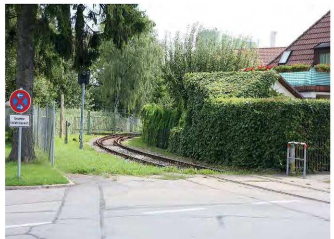
... Gleis befindet sich der Zungenbereich einer Bogenweiche mit dem Handstellhebel. Kurz dahinter folgen zwei weitere Weichen. Mit dem engen Radius, dem sehr „dichten“ Umfeld und dem vielen Grün handelt es sich um eine durchaus modellgerechte Situation – nicht unbedingt für den exakten Nachbau, aber als interessante Anregung, um sich gestalterisch vom üblichen Bild der Anschlussgleise abzuheben.
