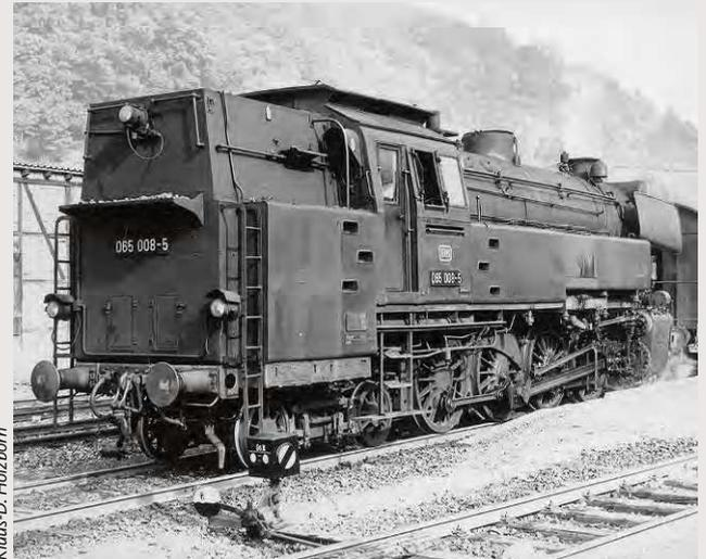
**Rückansicht der 065 008 mit den DB-Reflexglasleuchten**
