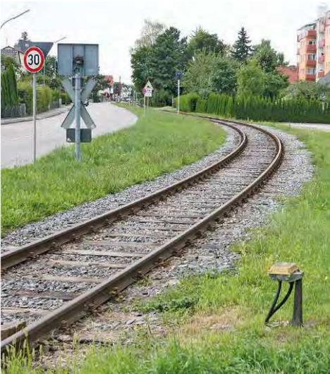
Links: Die Absicherung des Bahnübergangs mit einer Blinklichtanlage und einem Blinklicht-Überwachungssignal (siehe Foto auf der vorherigen Seite) sowie die blanken Schienenköpfe deuten auf eine regelmäßige Nutzung des Gleises hin.
