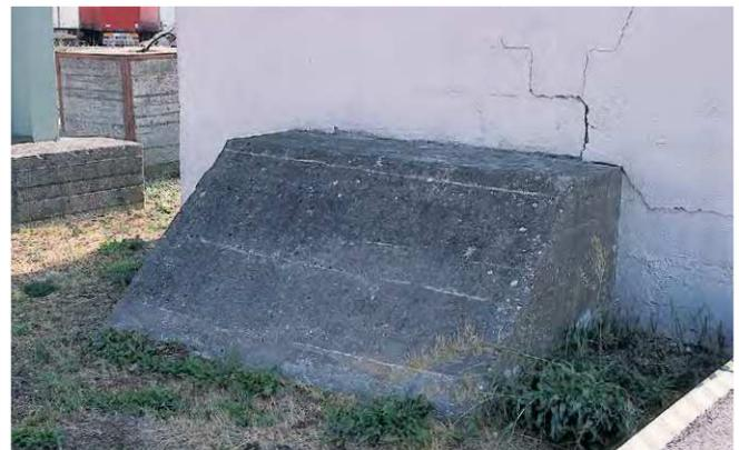
... gesichert. Die genau vom Bereich eines Puffers ausgehenden Risse in der Wand sind ein Beleg für die Sinnhaftigkeit dieser einfachen, aber effizienten baulichen Maßnahme.
