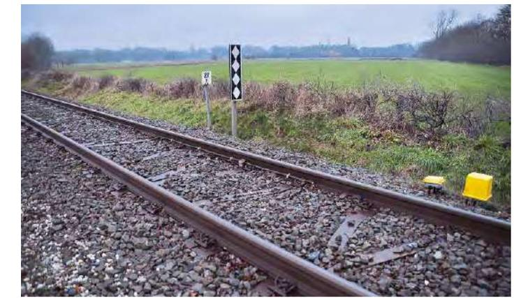
Y-Schwellengleis bei den Harzer Schmalspurbahnen bei Wernigerode
