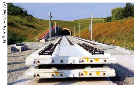
**Feste Fahrbahn der Bauart Bögl bei Hepberg an der Strecke Nürnberg – Ingolstadt – München (links) sowie während des Baus der Neubaustrecke bei Erfurt-Bischleben (rechts)**
