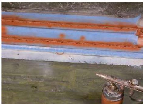
Zum Lackieren der Kleineisen und Schienenflanken mit rostbrauner Farbe wurden die umgebenden Bereiche abgeklebt
