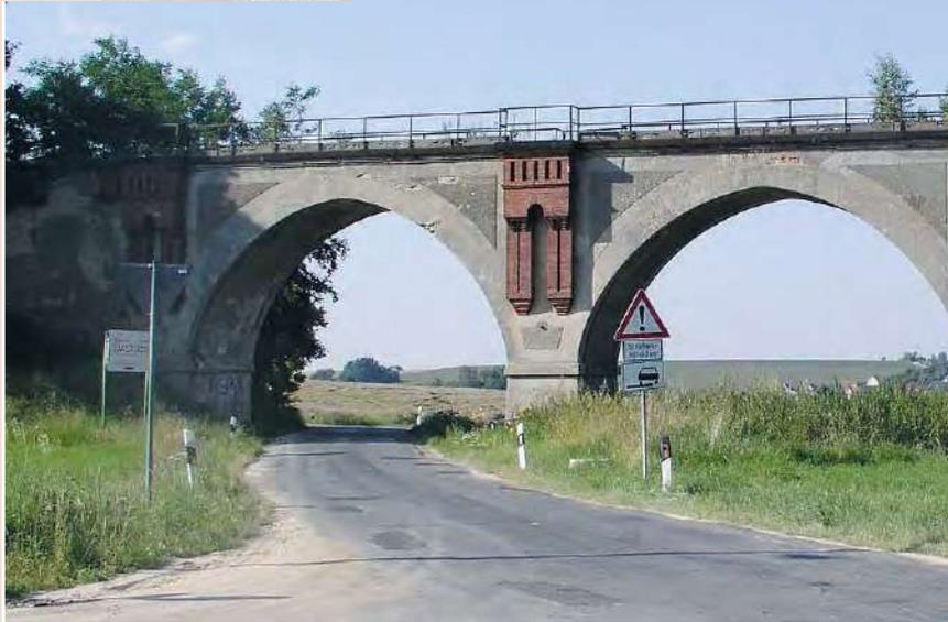
Weite Bereiche dieses in Ziegelmauerwerk errichteten Viadukts sind mit Beton verputzt worden, was einen Nachbau vereinfacht. Neben den unterschiedlich strukturierten Oberflächen sollten auch die leicht gotischen (oben „angespitzten“) Bögen beachtet werden. Als das Foto im August 2004 entstanden ist, war die Strecke Altenburg – Langenleuba-Oberhain längst stillgelegt.
