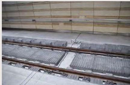
**Feste Fahrbahn der Bauart Rheda im Bahnhof Rheda-Wiedenbrück (links) und der Bauart Rheda 2000 mit Schallabsorber-Platten im Leipziger CityTunnel (rechts)**
