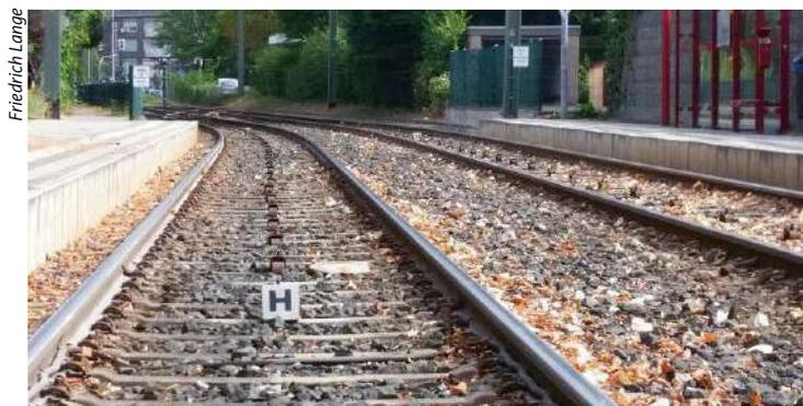
**Straßenbahngleise in Dinslaken mit tief im Gleisbett verankerten Schwellen, was dazu dient, die Schwellenlage zu stabilisieren**
