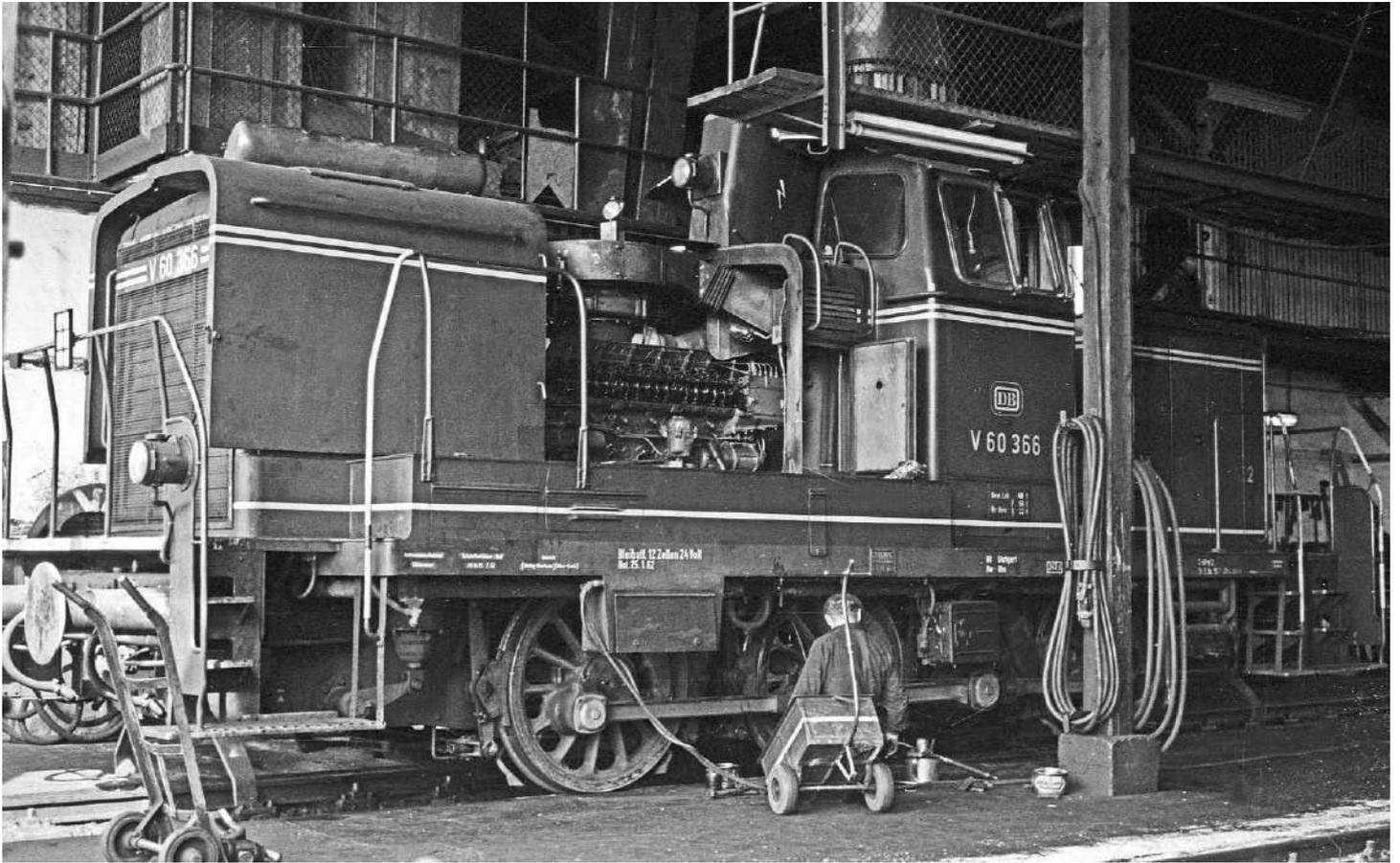
**Der Werkstattaufenthalt zeigt V 60 366 mit dem großen Fahrdieselmotor; dieser Typ wurde auch in den SVT verwendet**
