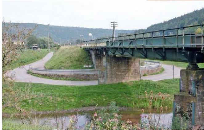
Die Brücke von Gräfendorf aus zwei weiteren Perspektiven. Die Darstellung der beiden schmalen, parallel in einem 180°-Bogen verlaufenden Straßen würde im Modell sicherlich reizvoll wirken und nur wenig Platz beanspruchen. Weitere Details sind die Kipp- und Walzenlager der Brückenträger, die schlichten Geländer, an ...
