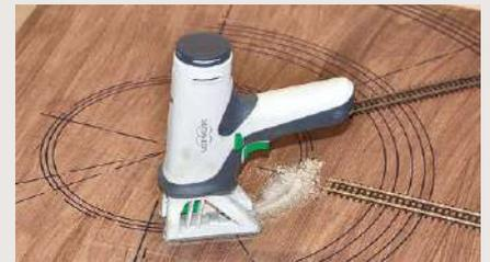
**Mit der Akku-Stichsäge und dem Clean-CurveWood-Sägeblatt von Vorwerk wird das Loch für die Drehscheibe gesägt**
