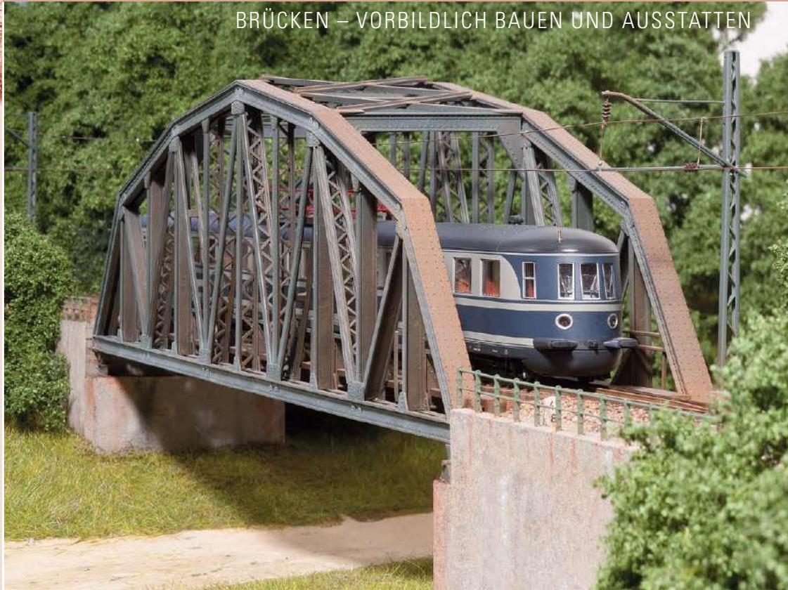
Die gut 72 m lange Zschopaubrücke der Wilischthalbahn steht in einem deutlichem Kontrast zu den zuvor gezeigten großen und massiven Brückenbauwerken. Die fast schon zierliche Ausführung ist typisch für Schmalspurbahnen mit ihren deutlich geringeren Lasten.
