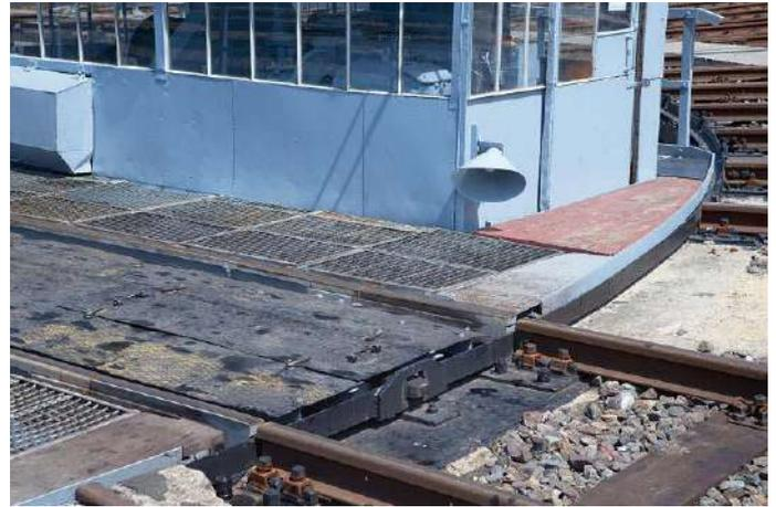
Bühnenverriegelungen auf beiden Seiten der befahrbaren Brücke
