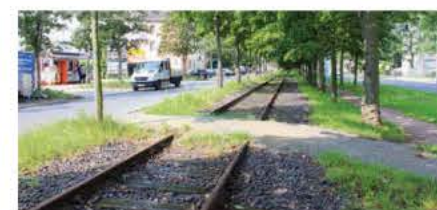
Noch ist die Güterstrecke in Neu-Isenburg ungenutzt. Bald sollen hier wieder Züge fahren
