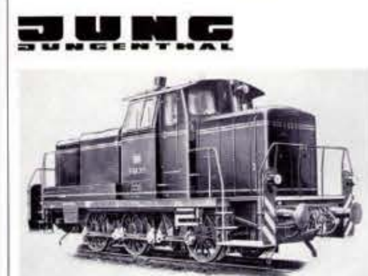
Beim V 60 der Deutschen Bundesbahn, ab 1955 im Bau, Ausgestattet mit Maybach-Dieselmotor Typ GTO 6 und Voith-Flüssigkeitsgetriebe L 37. Eine größere Serie des V 60 für die Deutsche Bundesbahn bestellte sich zur Zeit in der Fertigung.
