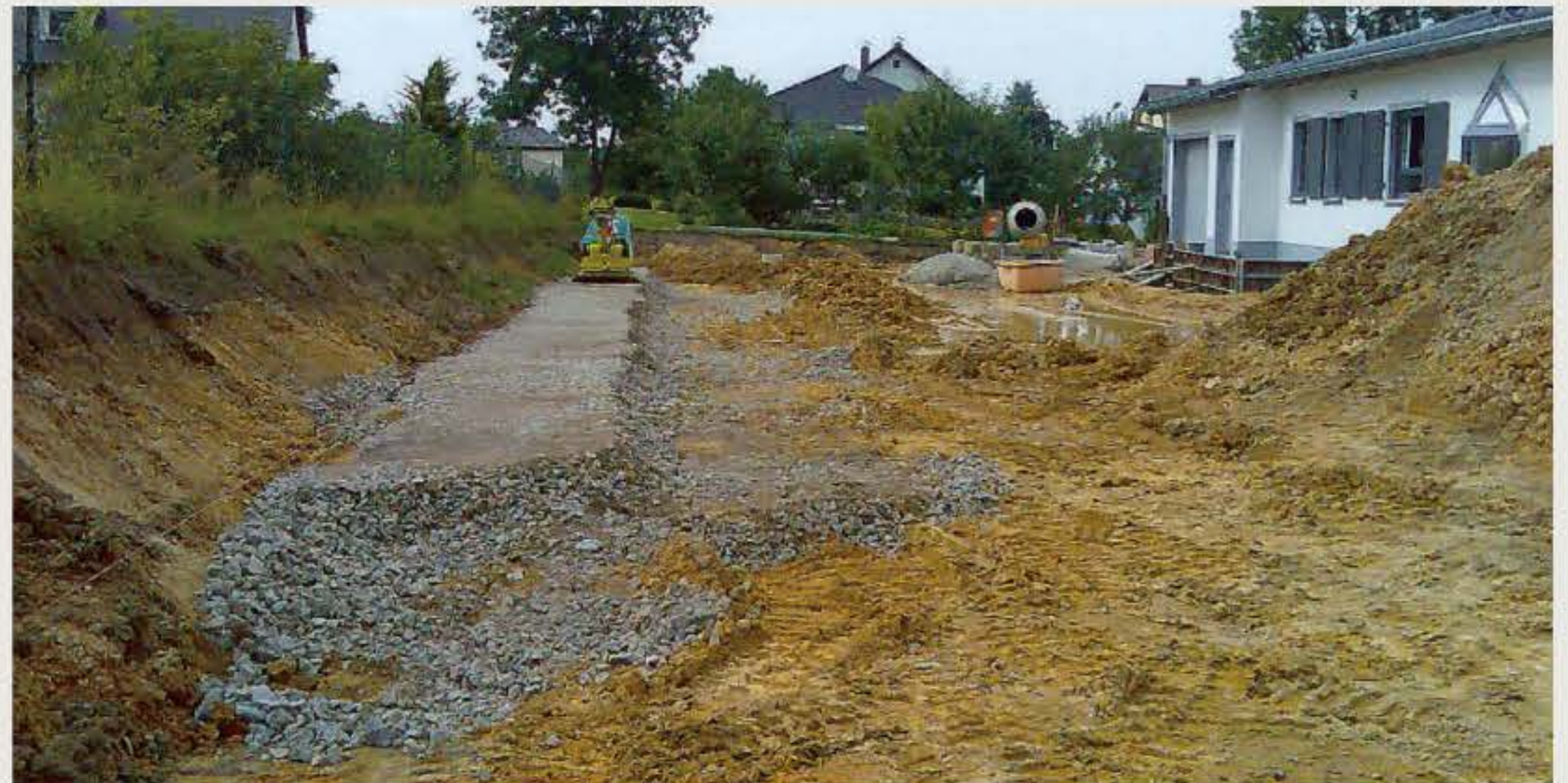
Zunächst wird eine Schottererschicht als frostfreie Gründung angelegt
