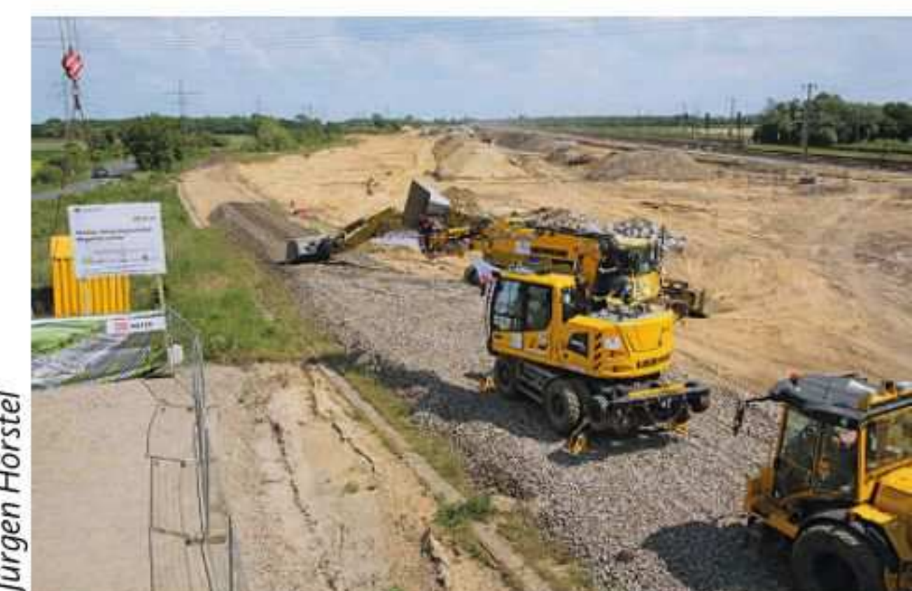
Auf dem Gelände des ehemaligen Rangierbahnhofs Lehrte entsteht eine der modernsten Container-Umschlaganlagen Deutschlands
