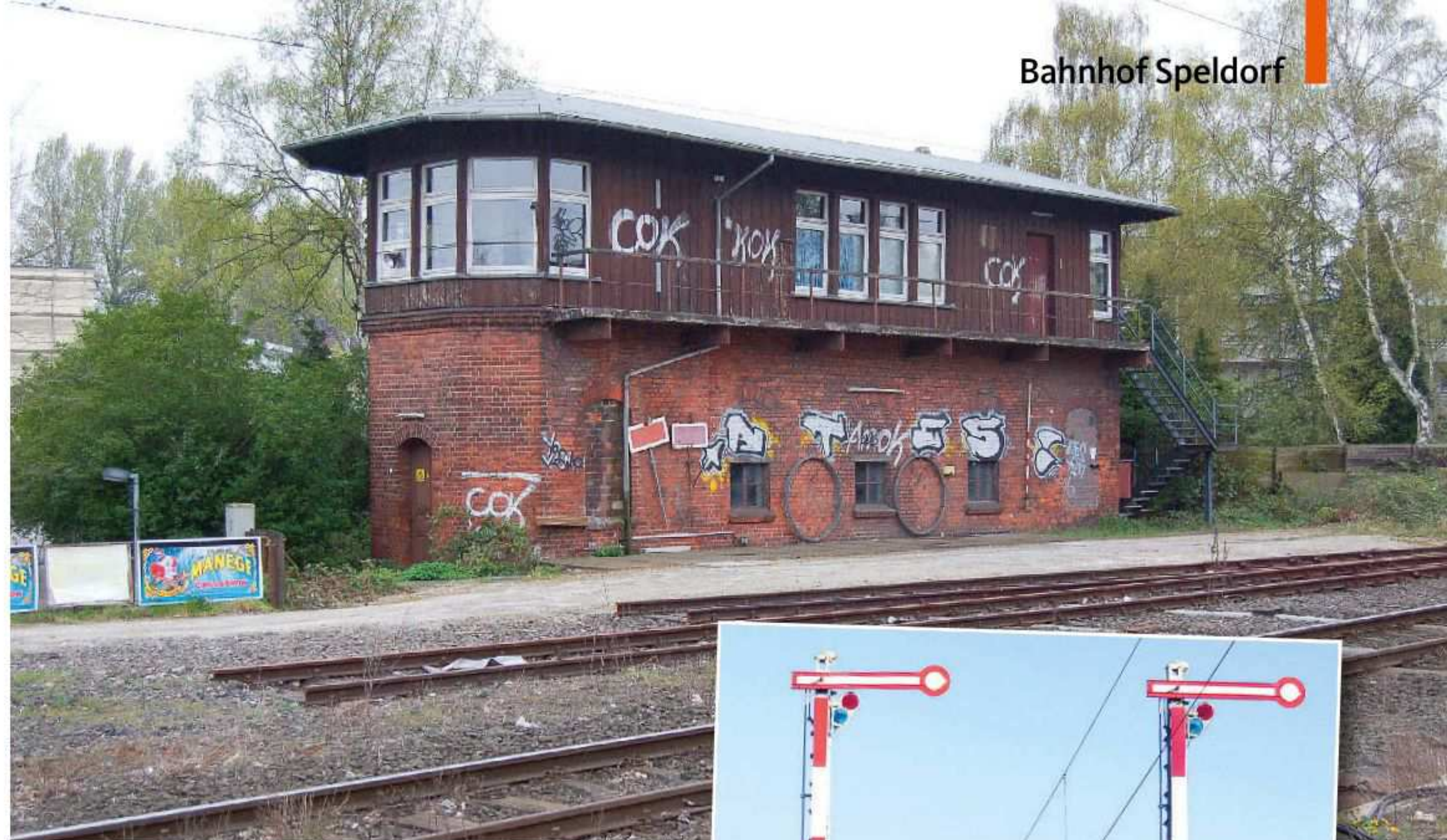
Nach dem Abbruch des Stellwerks Msf über- nahm das ehemalige Stellwerk Msw, hier noch mit dem inzwischen abgebautem Balkon, alle Aufgaben. Die Signale und Weichen werden von der stark zurückgebauten Hebelbank bzw. vom Stellpult auf dem Schreibtisch aus gestellt
