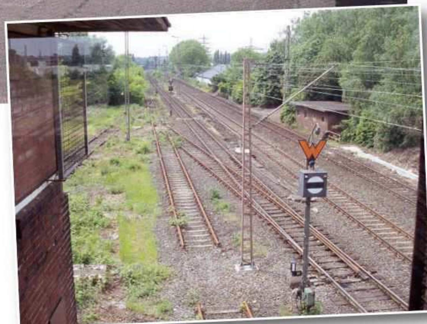
Während am 21. Juni 1968 noch Personenzüge in Speldorf hielten und vom Stellwerk Msf (hinten rechts) den Fahrauftrag bekamen, starteten 2005 die Rückbauarbeiten an Gleisen und Oberleitung
