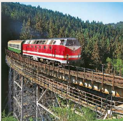
Die Ziemesttalbrücke der Thüringer Oberlandbahn in der Epoche V mit 219-be-spanntem Personenzug nach Lobenstein
