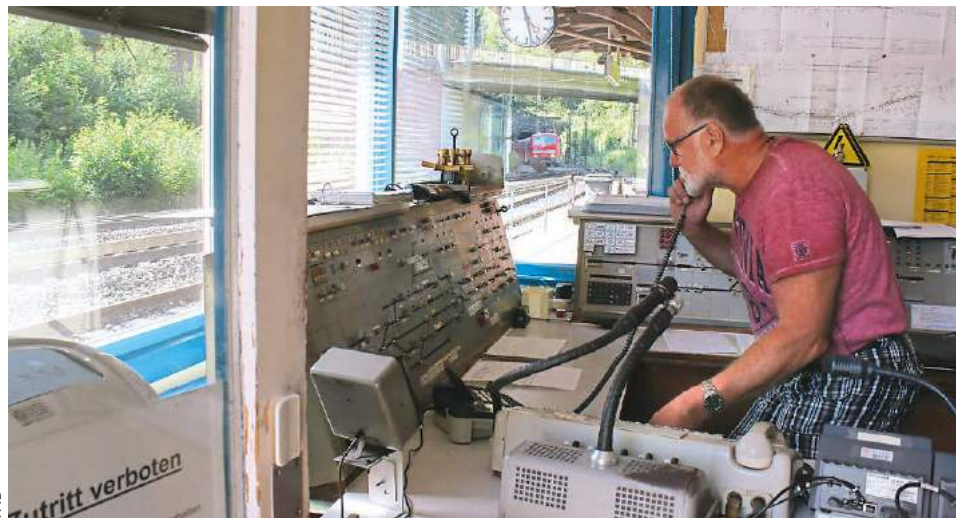
Noch regeln in Heigenbrücken Fahrdienstleiter wie Christian Auth den Zugbetrieb (Foto vom August 2016). Im Juni 2017 wird der Bahnhof komplett aufgelassen
