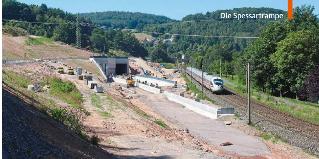
Im August 2016 nimmt der neue Haltepunkt Heigenbrücken Ost bereits merklich Gestalt an. An dieser Stelle fädelt die Umfahrungsspange in die Bestandsstrecke ein
