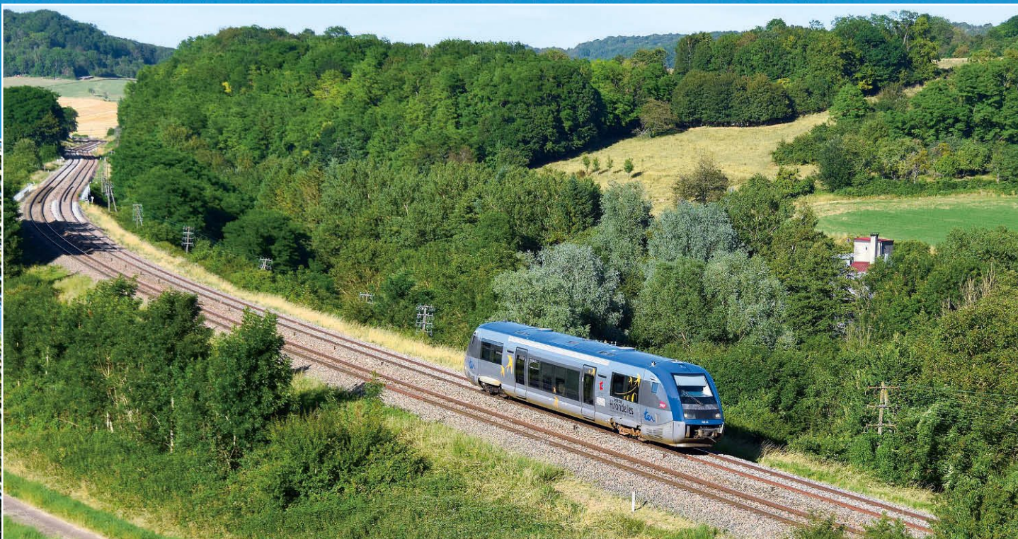
Telegraphenleitungen und Gleisverschwenkungen belegen: Die Ligne 4 präsentiert sich in weiten Teilen noch ursprünglich. Im Nahverkehr zwischen Vesoul und Belfort fahren „Walfische“ (SNCF-Baureihe X 73000, hier bei Colombier im Juli 2016)
