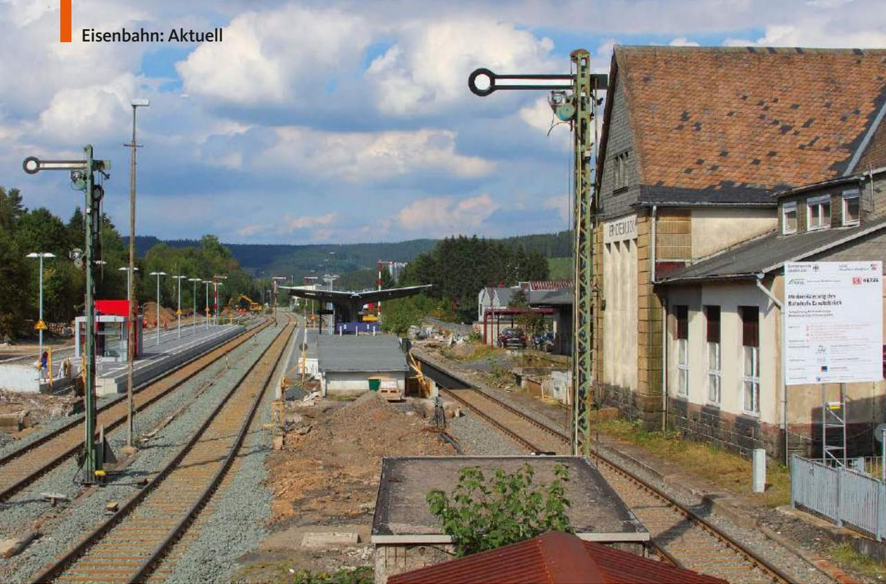
**Blick aus dem Stellwerk Erndtebrück: Nicht nur die Zugleittechnik ändert sich: Die Bahnsteige werden umgebaut und erhalten einen Aufzug, zahlreiche Weichen werden ausgetauscht und die Gleise 1 bis 4 komplett erneuert. Insgesamt werden hier über zehn Millionen Euro investiert. Ende des Jahres 2017 soll alles fertig sein**
