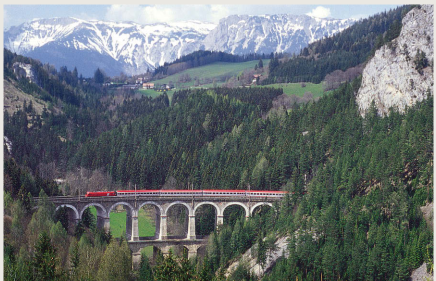
Die zum UNESCO-Weltkulturerbe zählende Semmeringbahn führt über zahlreiche Viadukte wie diesen im Mai 2014 aufgenommen an der Kalten Rinne
