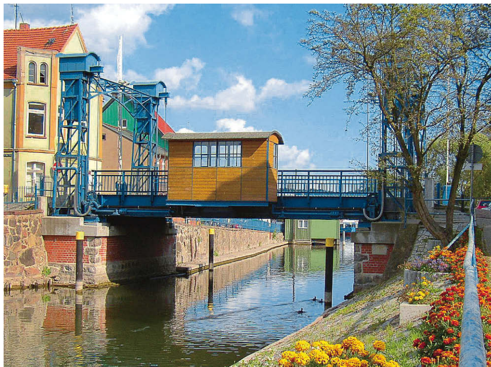
Als Vorbild diente die Hubbrücke in Plau am See
