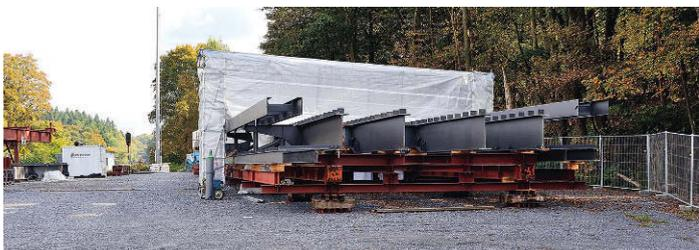
**Elemente der neuen Fahrbahnbrücke wurden 2013 auf einem Lagerplatz westlich der Brücke für den späteren Einbau vorgehalten**
