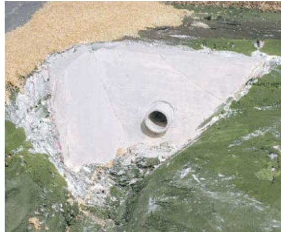
Innen: An den fertig bearbeiteten Gipswänden fallen die scharfen Eckkanten auf. Gut zu erkennen ist auch der vertiefte Sitz des Rohres.
