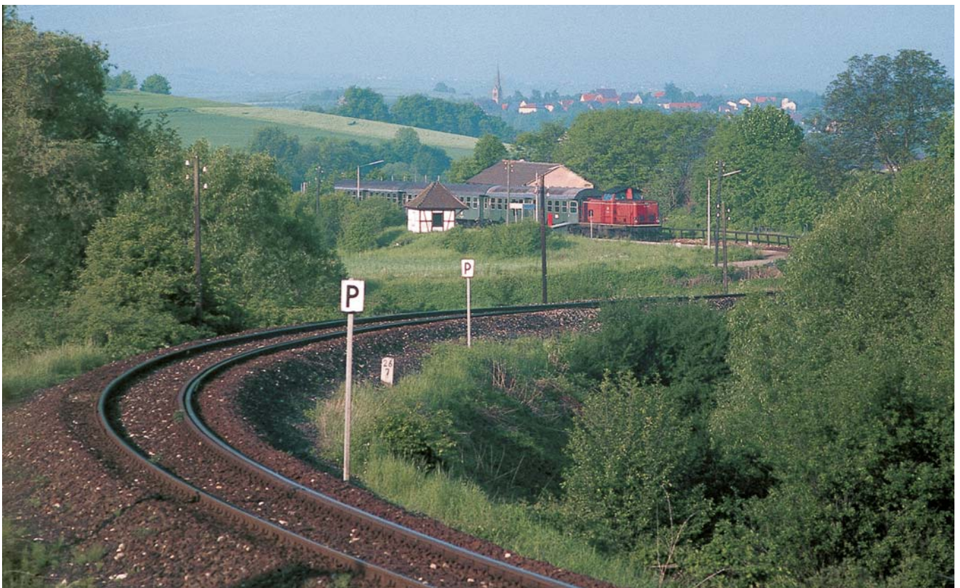
Kurz vor Gräfenberg wechseln sich einige enge Links- und Rechtskurven ab. Teilweise mussten die sicherheitshalber mit Zwangsschienen ausgestattet werden (Mai 1985). FOTO: RALF SCHMIDT
