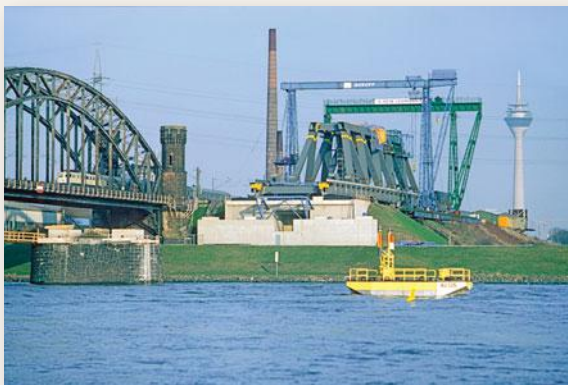
Februar 1985: Vormontage der Brückenteile auf der Düsseldorfer Seite.
