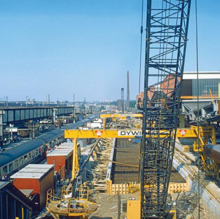
1981: Bau der U-Bahn, die die Gleise des Hauptbahnhofs quert, und die alten Bahnsteigdächer werden durch eine neue Halle (rechts) ersetzt.
