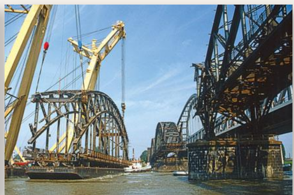
4. Juli 1987: Abtransport der alten Brückenbögen mit Schwimmkränen. Fotos: E. Pempelforth (5)
