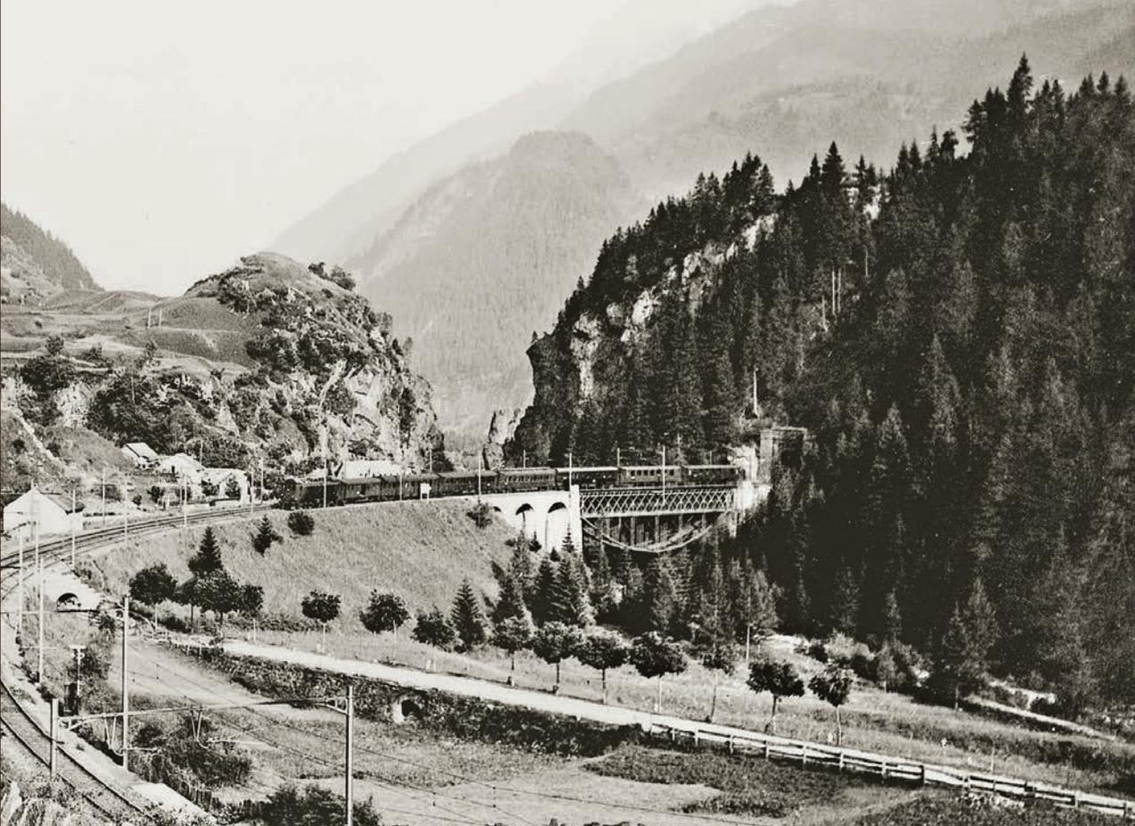
Links: Blick auf den Stalvedro-Viadukt (101 m), kurz vor Airolo, mit einem bergwärts fahrenden Reisezug, gezogen von einer Be 4/6. Die Brücke wurde aus Stabilitätsgründen mit einem Fischbauchträger verstärkt und in den 1950er Jahren zur Bogenbrücke in Betonbauweise umgestaltet. Unten: Sehr aufwändiger Zwischendienst bei einem schweren Kohlenzug nach Italien, gebildet aus belgischen Wagen, aufgenommen im Bahnhof Airolo.
