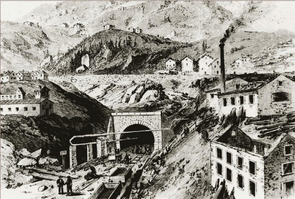
Das Südportal des im Bau befindlichen Gotthard-Scheiteltunnels in Airolo. Auffallend: das in den Tunnel führende Rohrsystem.
