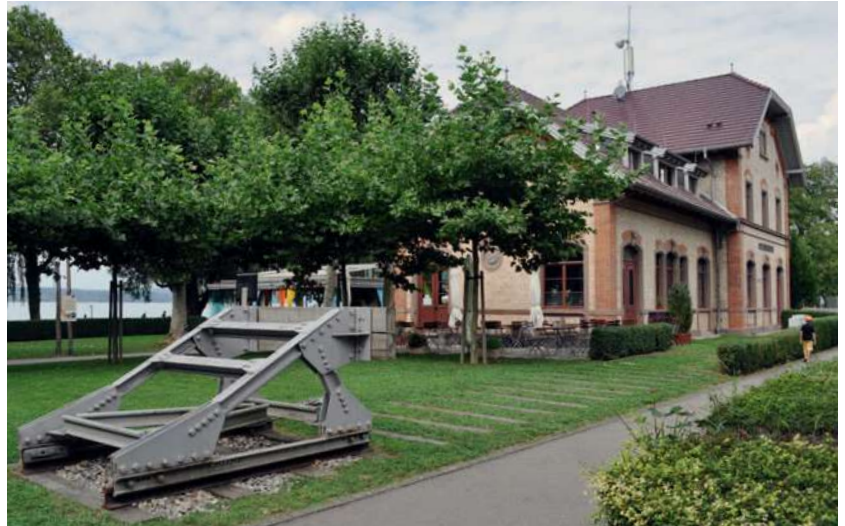
Die kurze Stichstrecke von der Bodenseegürtelbahn nach Unteruhldingen wurde schon 1950 stillgelegt, das Empfangsgebäude blieb erhalten (September 2016). Foto: W. Willhaus
