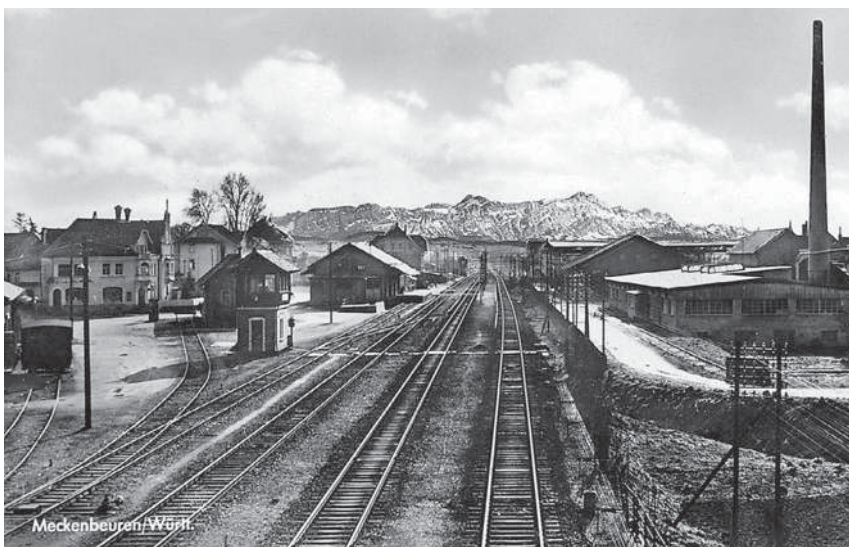
Meckenbeuren: Der durchgehende Betrieb auf der Südbahn Friedrichshafen–Ulm begann 1850, auf dem ersten Abschnitt Friedrichshafen–Ravensburg schon am 8. November 1847.
