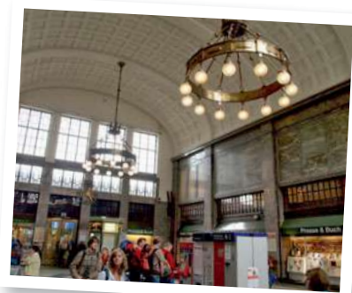
Lindau Hbf: Eingangshalle mit schmutzigen Leuchtern (2007). Foto: G. Dillig
