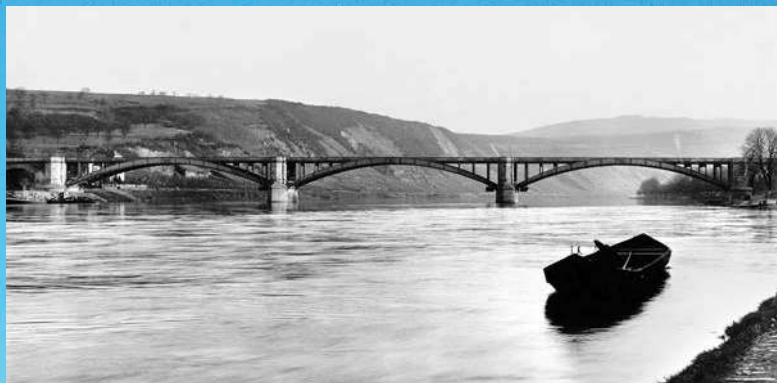
1927 hatte die Brücke bei Güls verstärkte Überbauten erhalten. FOTO: SLG. KANDLER
