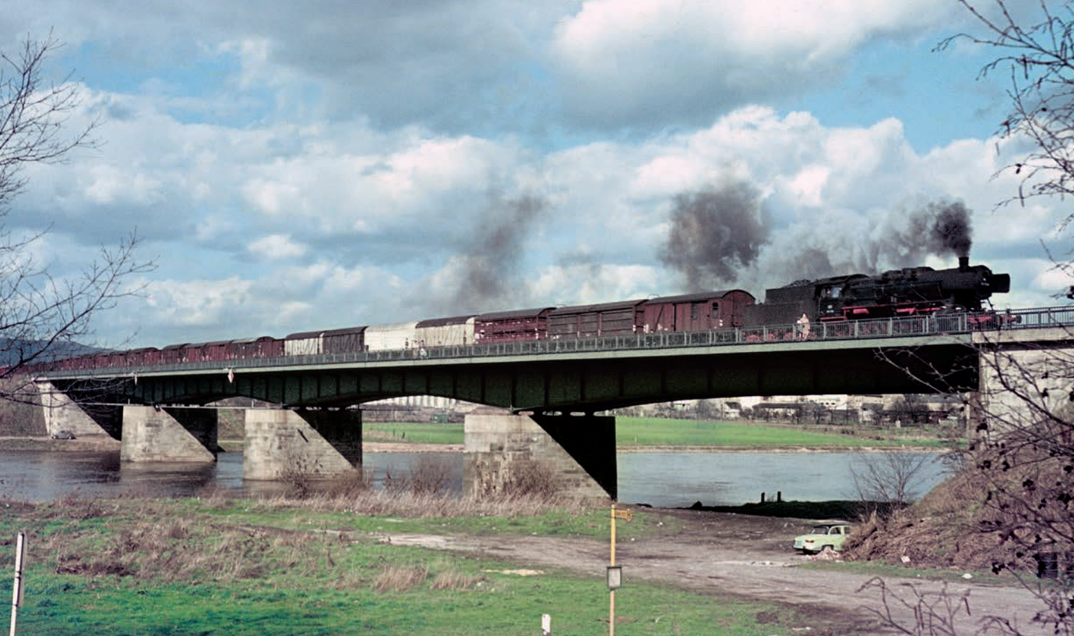
Ende 1957 wurde der Neubau der Brücke bei Trier-Pfalzel in Betrieb genommen, die hier ein Güterzug mit 50 1738, im März 1967 befährt. Das Bauwerk ist die kürzeste der vier Moselbrücken von Koblenz aus.
