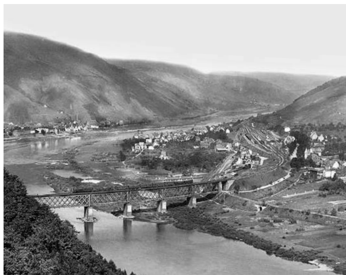
Die doppelstöckige Brücke in Bullay präsentiert sich hier Mitte der 20er Jahre noch mit den ursprünglichen Überbauten, befahren von einem Zug mit P 8 Richtung Trier.
