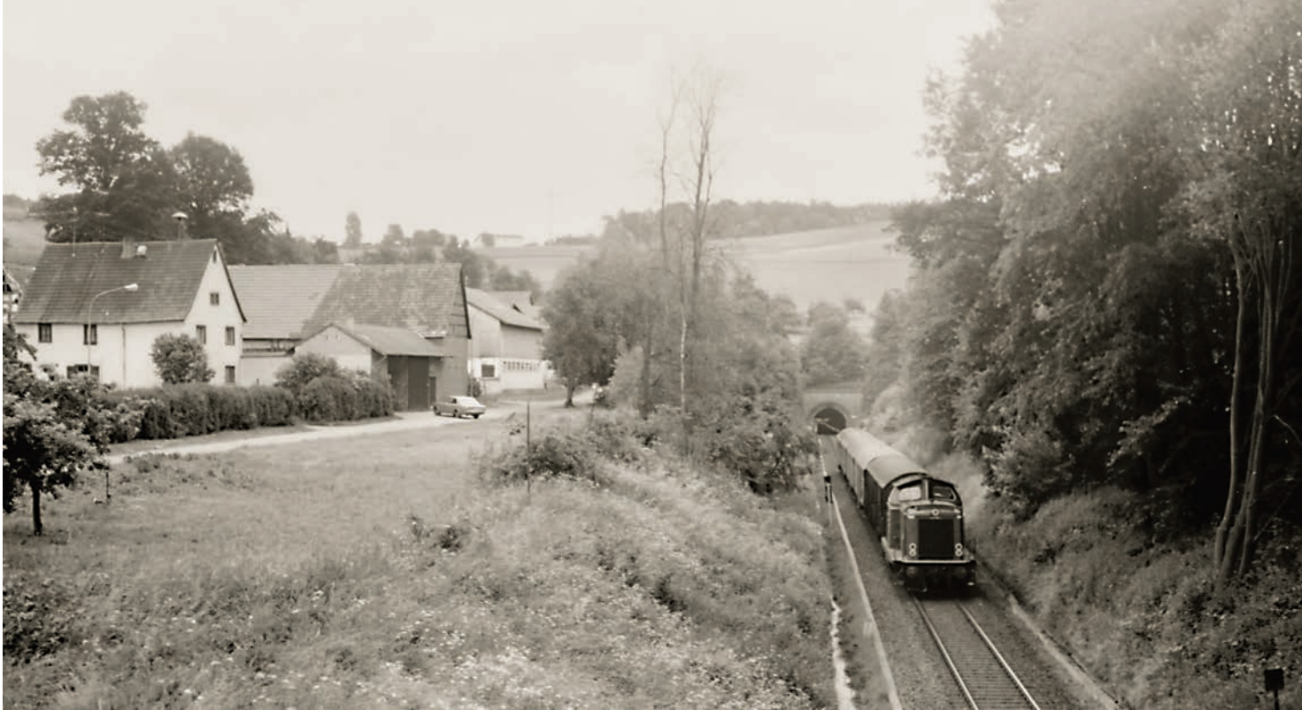
1205 Meter lang ist der Frau-Nauses-Tunnel bei Wiebelsbach-Heubach als zweitlängster Tunnel der Odenwaldbahn (N 6626 am Nordportal, 23. Juni 1980).
