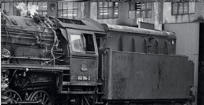
Die ölgefeuerten Loks waren nicht nur am Ölbunker des Tenders zu erkennen. Sie hatten auch zusätzliche Dampfleitungen linksseitig vor dem Führerhaus.
