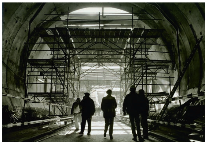
Februar 1999: Die Bauarbeiten am Wandersmann-Tunnel der Schnellfahrstrecke Köln – Rhein/Main beginnen, hier Tag des offenen Tunnels.
