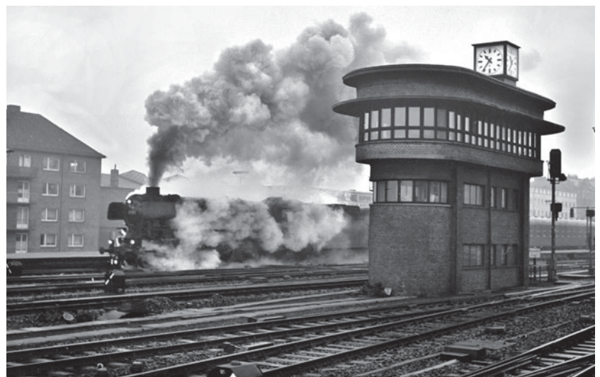
01 1092 dampft im Juni 1958 am Dr-Stellwerk Af vorbei, das 1952 in Betrieb gegangen ist.
