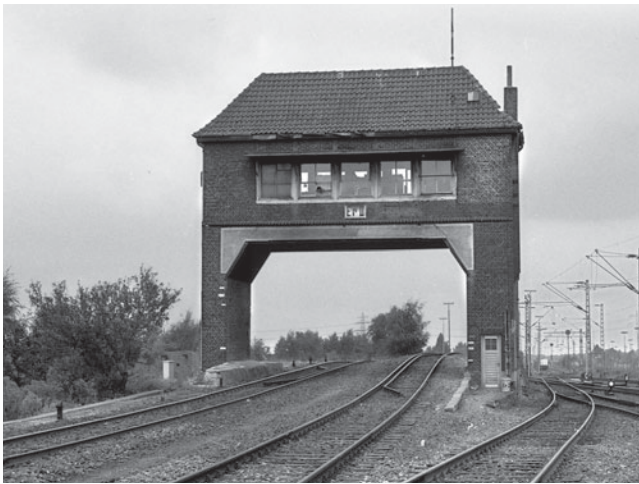
Hamburg-Eidelstedt Rbf: Ablaufstellwerk Er II mit Sommer- und dem höheren Winterberg (1975). Foto: B. Wiesmüller
