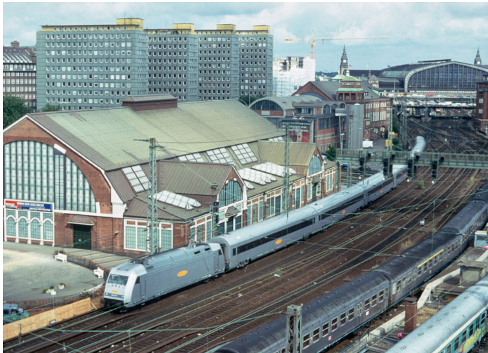
101 131 mit dem Metropolitan Express Train (MET) 936 nach Köln hat am 13. August 1999 den Hauptbahnhof Hamburg verlassen. Fotos: K. Koschinski, A. Ritz (unten)
