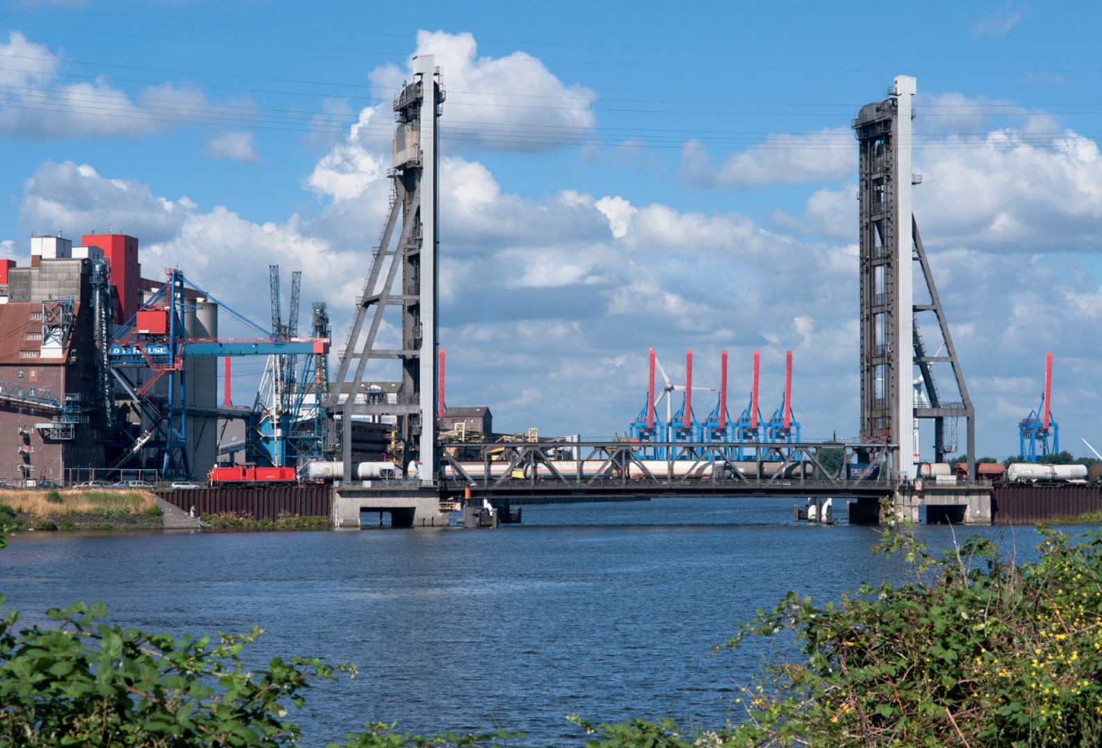
Eine 295 der Deutschen Bahn überquert am 18. Juli 2010 mit einem Güterzug nach Hohe Schaar die Rethe-Hubbrücke. Foto: J.-G. Lukner
