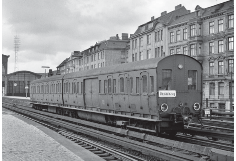
Der ET 174 001 a/b entstand durch Umbau eines Wechselstrom-Triebwagens und wurde als Gepäckzug eingesetzt (1961). Foto: J. Claus/Archiv Eisenbahnstiftung
