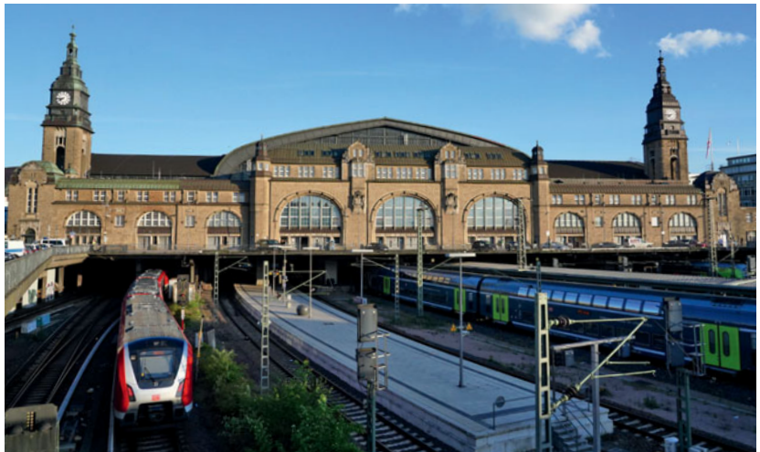
Die Nordseite des Hauptbahnhofs bei Tageslicht: Ein S-Bahn-Zug der Baureihe 490 fährt soeben ein (Mai 2019). Fotos: V. Emersleben (2)
