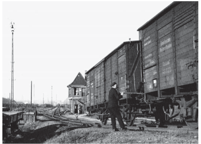
Verschiebebahnhof Harburg: Abhänger am Süd-Nord-Ablaufberg mit Stellwerk Abl im Hintergrund (um 1930). Foto: Slg. Apel
