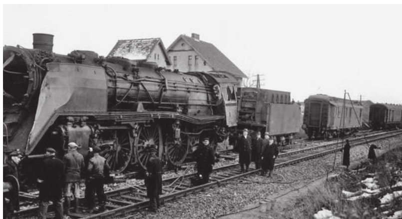
03 174 nach dem Kesselzerknall bei Greiffenberg (21.3.1939). Foto: RVM/Eisenbahnstiftung
