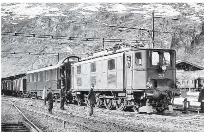
Der Simplon-Tunnel erhielt 1906 eine zweipolige Fahrleitung: Fb 4/6 Nr. 371 (Baujahr 1914) mit Probe-Güterzug in Brig. Werkfoto BBC/Slg. Niedt
