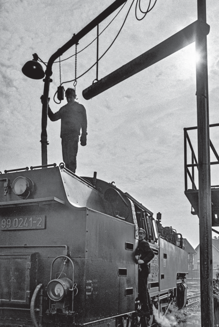
Ab 1974 waren alle 17 Exemplare der Baureihe 99 23-24 in Wernigerode Westerntor beheimatet und erhielten bis 1981 eine Ölhauptfeuerung. Die 99 0241 ergänzt im April 1981 in Wernigerode ihren Ölvorrat. Foto: K. Risch/Bildarchiv der Eisenbahnstiftung
