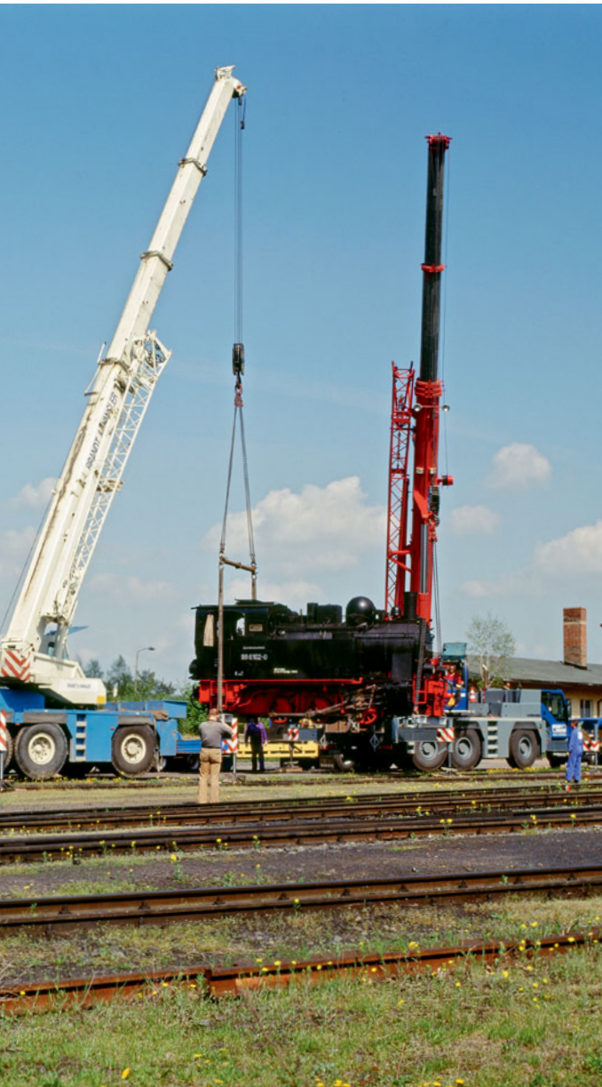
Loktransport per Tieflader: Die 99 6102 ist am 27. April 2004 zurück in Gemrode. Foto: W. Bley
