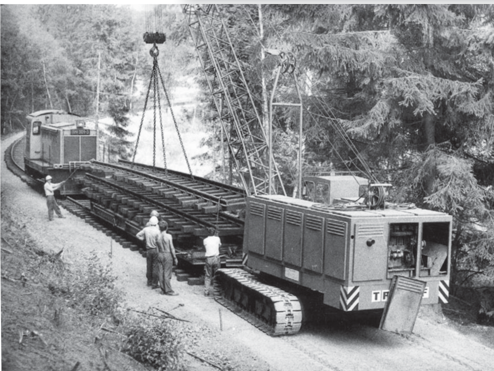
Wiederaufbau des Abschnitts Straßberg – Stiege im August 1982. Die 199 301 half mit. Foto: W.-D. Machel
