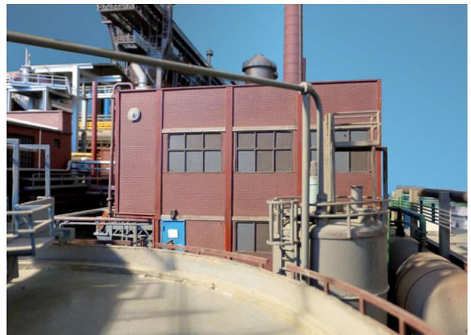
*Vorbild und Modell zum Vergleich: Blick vom Rundeindicker der Abwasserbehandlung auf das Pressengebäude. Dort wird dem Zinkschlamm aus dem Rundeindicker die Feuchtigkeit entzogen.*
