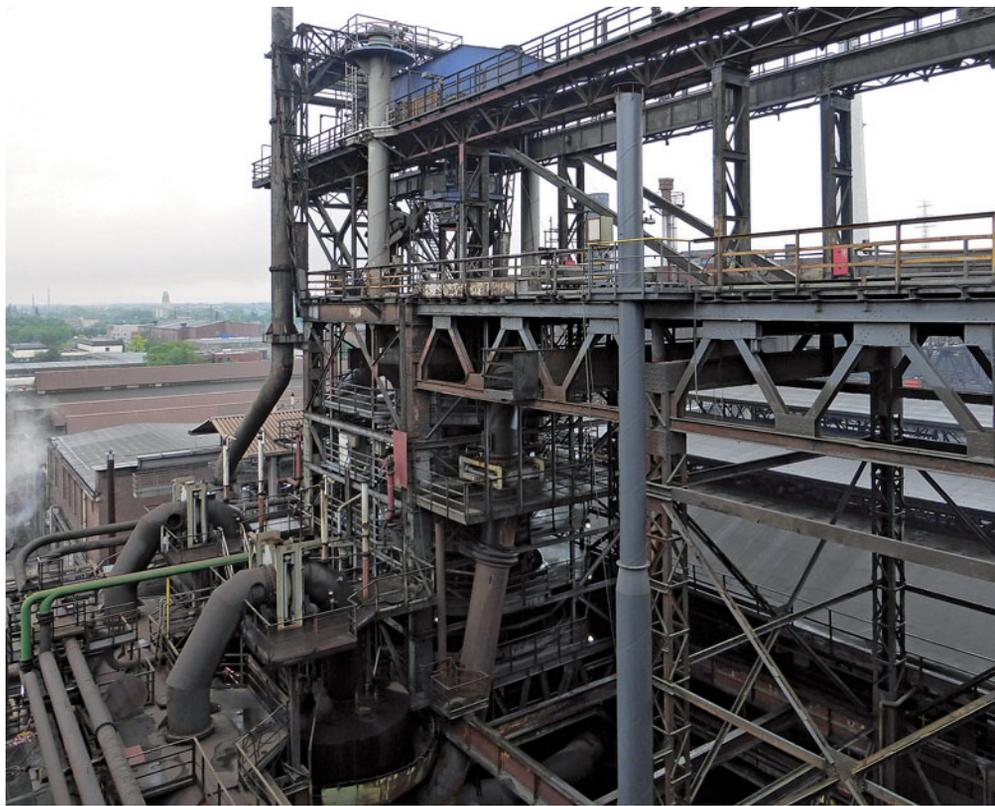
*Oben: Ein Ausschnitt des Hochofengerüsts mit dem Reserveofen 4. Oben auf der Kranbahn läuft eine der beiden automatischen Laufkatzen. Links unten sieht man die Staubsäcke, deren Ableitungen in die dicke Sammelleitung zur Gasreinigung münden. Hinter dem Gerüst ist das Dach der Gießhalle zu erkennen. Das Foto rechts zeigt die gleiche Situation im Modellmaßstab 1:87.*
