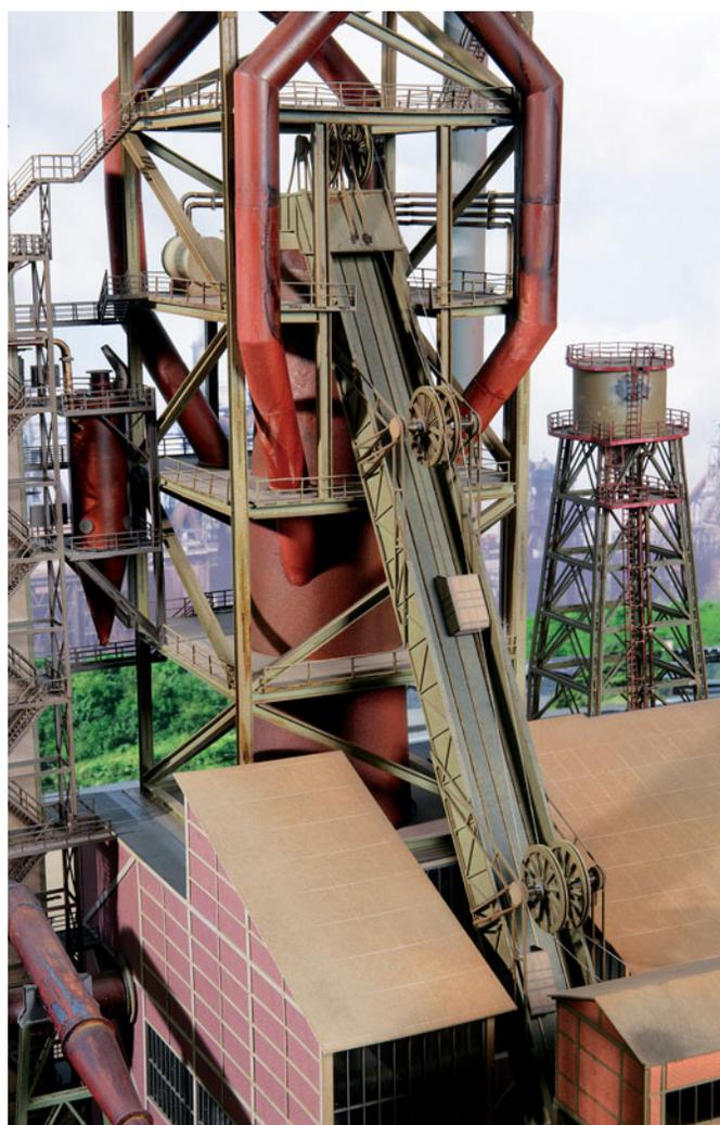
Der lange Schrägaufzug zur Begichtung des Hochofens führt bis in den Tiefbunker (Foto rechts), der direkt von Eisenbahnwaggons...
