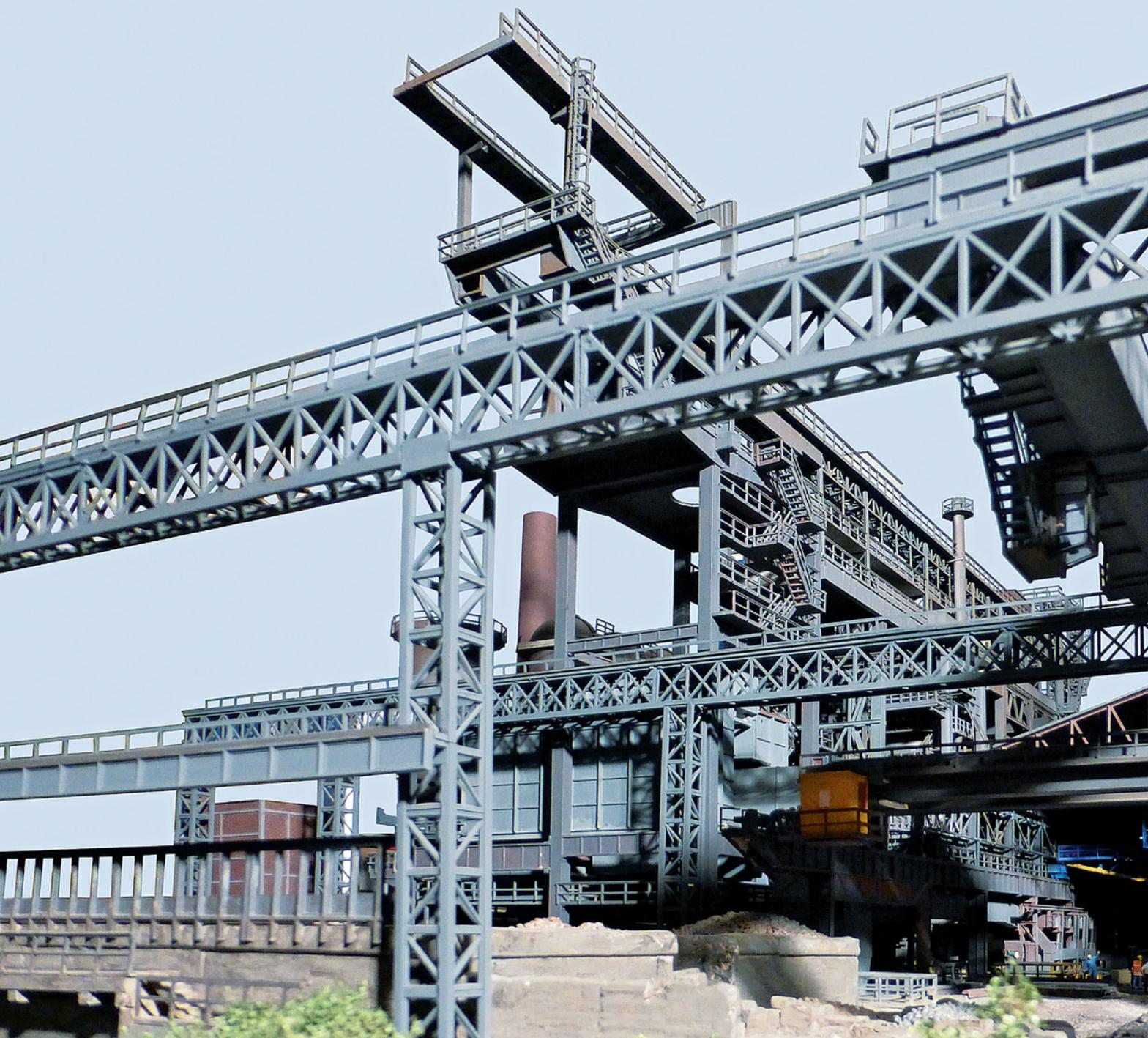
*Gießhalle und Hochofengerüst hinter der Roheisenbahn. Auch beim Roheisenkran fehlt noch das Krangeschirr. Die Gießhalle ist eigentlich eine teilüberdachte Kranbahn ohne Seitenwände.*
