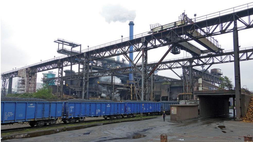
*Links: Die Hochofenanlage hinter der Roheisenkranbahn. In der Bildmitte steht ein Koksganzzug, gebildet aus Eaos der PKP.*
