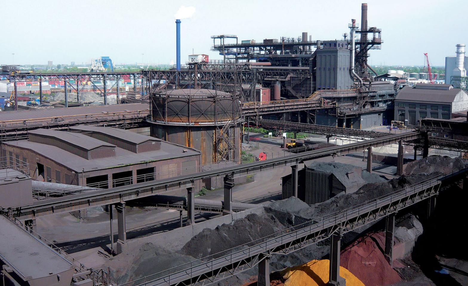
dem Gichtgas, Schlacke für die Bauindustrie und der Stromüberschuss aus dem betriebseigenen Kraftwerk, dessen Turbinen mit dem Gichtgas betrieben werden.
