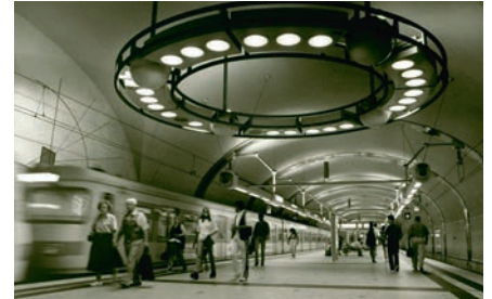
März 1988: Bei der S-Bahn Rhein/Main beginnt der zweite Bauabschnitt.
