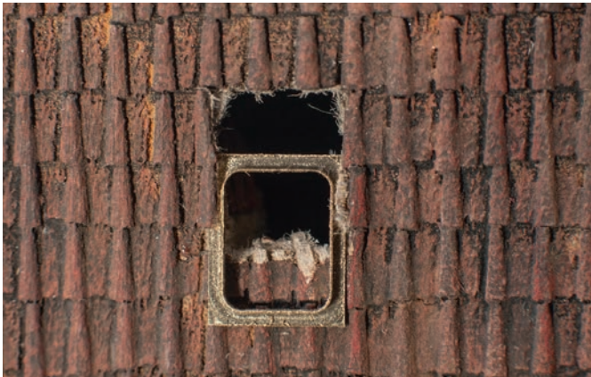
Von unten wird das Dachfenster in die vorgeschchnittene Lücke geschoben.
