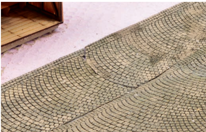
Fugen im angestückelten Bereich werden später mit Sand getarnt.
