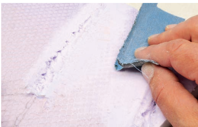
Mit grobem Schleifpapier lässt sich die Oberfläche gut glätten.
