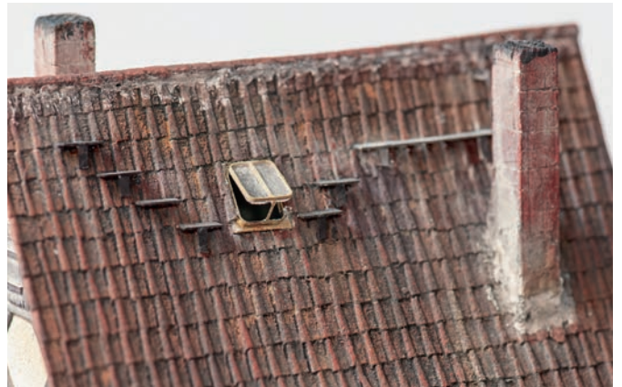
Die Dachausstattung mit Kamin, Schornsteinfegerluke und Tritten.
