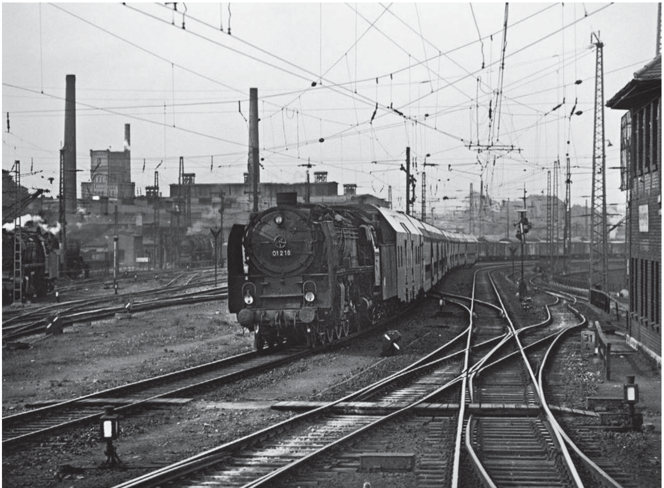
Am 18. Mai 1962 fährt die 01 218 mit zwei Doppelstock-Einheiten am Bahnbetriebswerk in Weißenfels vorbei. Foto: G. Illner/Slg. Garn
