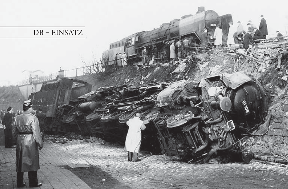
01 108 nach einer Flankenfahrt in Hamburg-Altona am 4. November 1954. Foto: DB/Slg. Griebel
